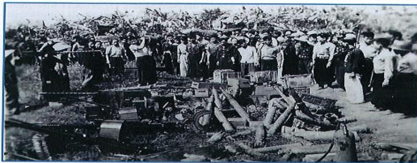
• Matériel récupéré par les plongeurs sur l'épave de la «Glycine» (D332) •
