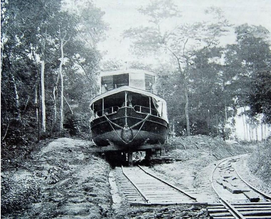
Fig.8 La chaloupe Le Garcerie transportée par voie ferrée pour le franchissement des rapides de Khône.
