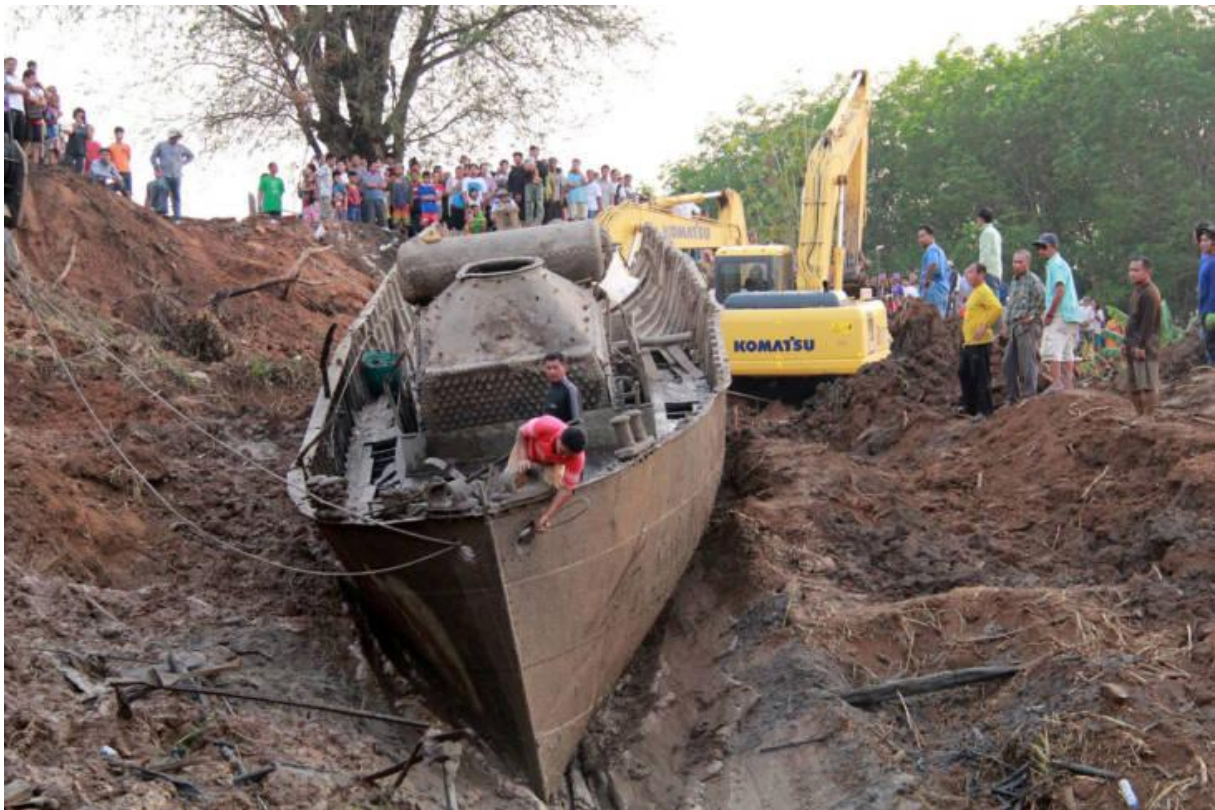
Fig.42 l'épave sur la rampe d'accès, presse locale, 28 février 2016.
