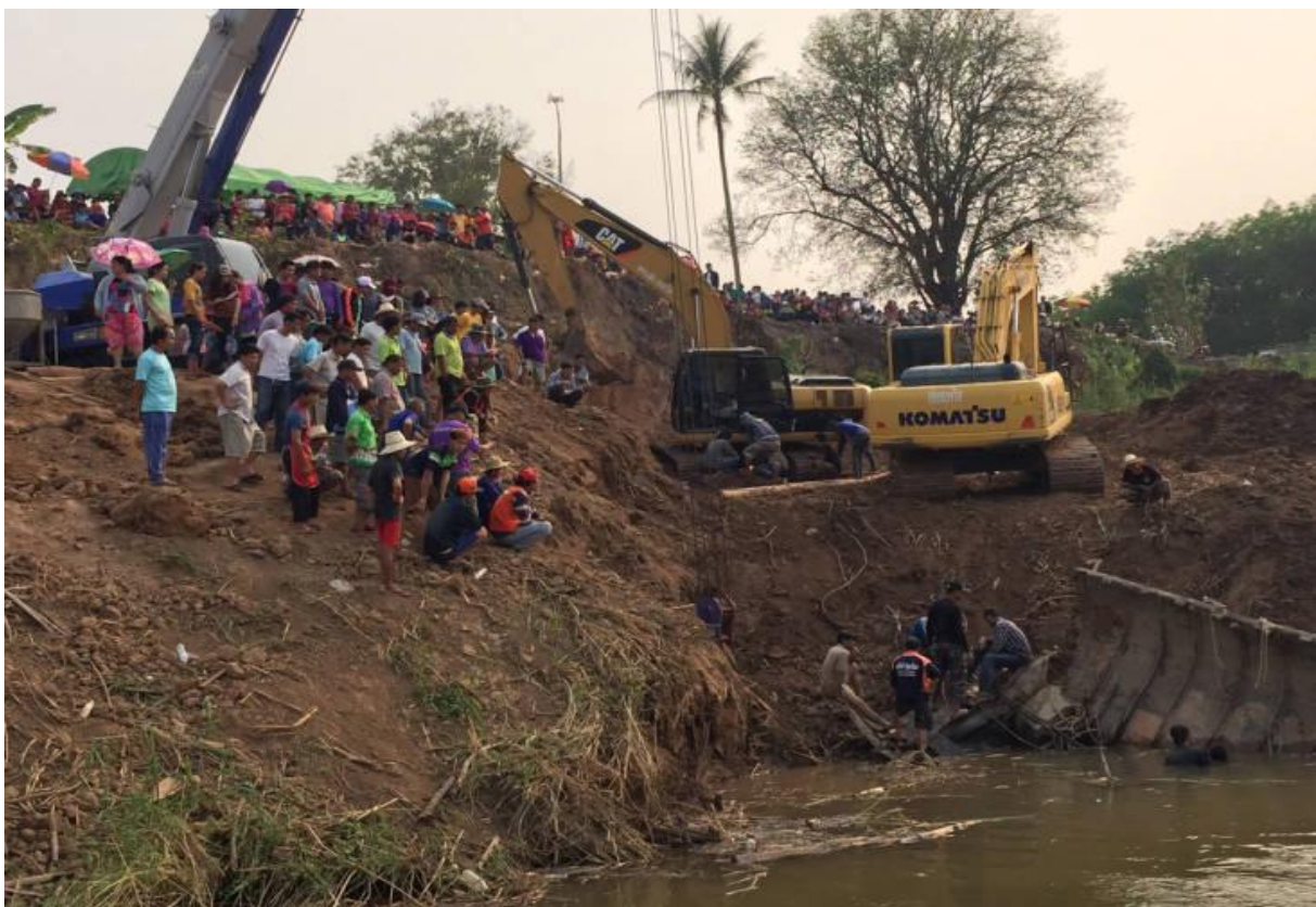
Fig.39 Aménagement d'une rampe d'accès par les pelles mécaniques, presse locale.
