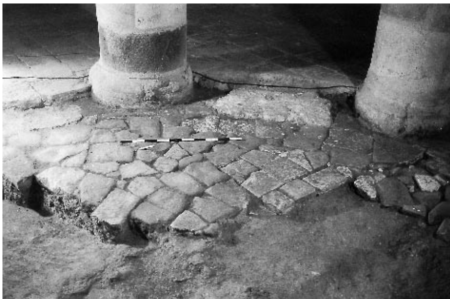
Fig. 16 : La rotonde, détail du pavage primitif conservé sous le dallage du XIX e s. (éch. 1 m).
