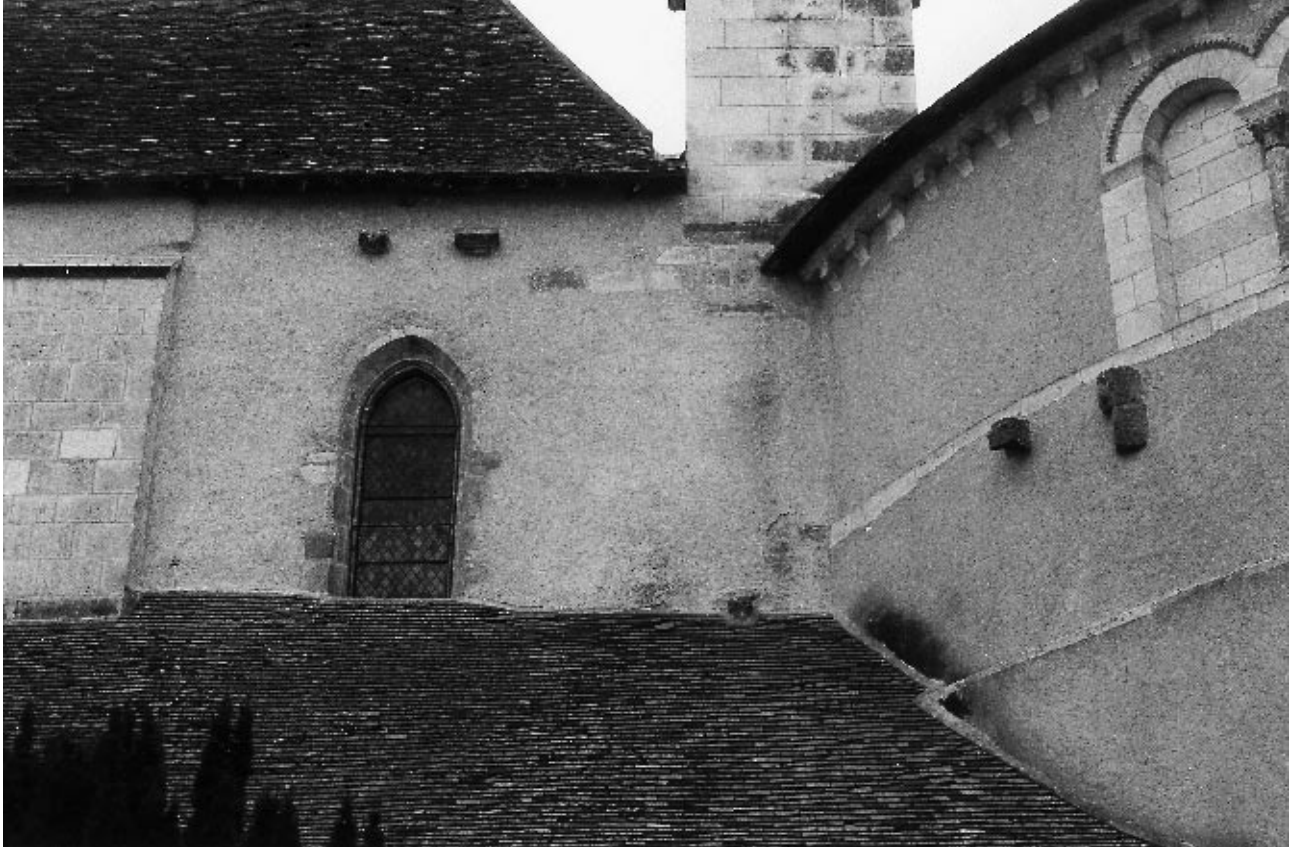
Fig. 6 : La liaison entre le mur nord de la nef et la rotonde. Juste en dessous de l'arcature de la rotonde, on observe l'arrachage du mur du bas-côté nord.
