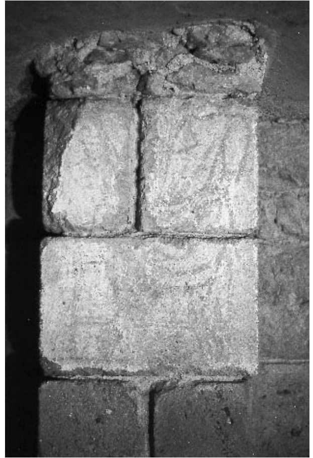
Fig. 12 : Le parement interne du mur nord de la nef, au sommet du pilastre de la travée 2. Détail d'un personnage assis tenant un sceptre (cf. Fig. 4b).
