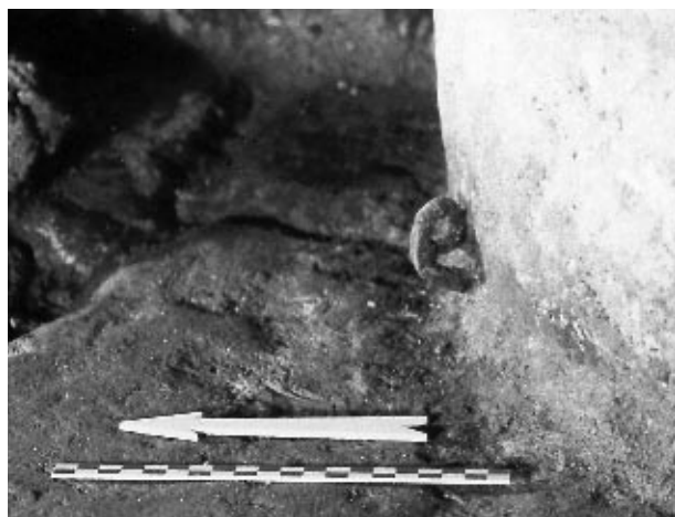
Fig. 17 : La rotonde, détail d'un crochet en fer scellé entre le sol et la base de la colonne IV (éch. 20 cm).
