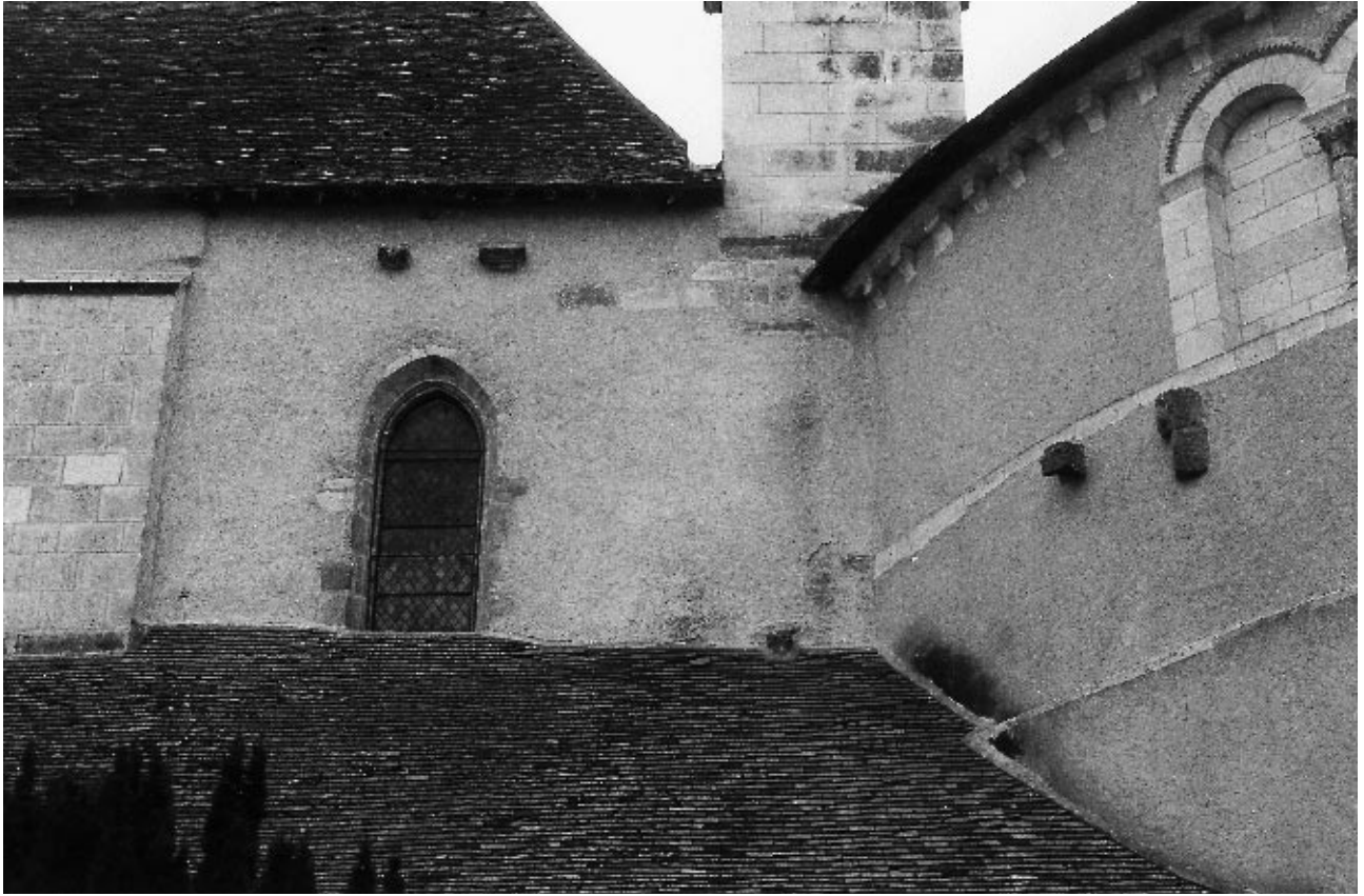
Fig. 6 : La liaison entre le mur nord de la nef et la rotonde. Juste en dessous de l'arcature de la rotonde, on observe l'arrachage du mur du bas-côté nord.
