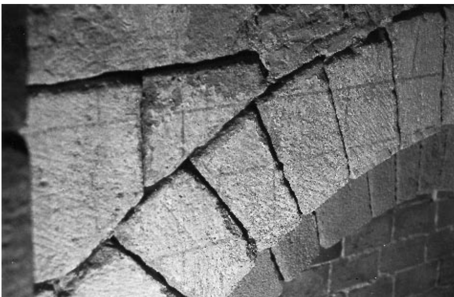
Fig. 11 : Le parement interne du mur nord de la nef, travée 1 : détail des faux joints sur fond blanc conservés au-dessus de la baie de la tribune. Notons que les "assises" ne respectent pas les claveaux (cf. Fig. 4a).
