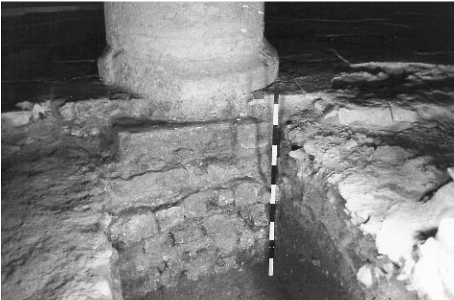
Fig. 19 : La rotonde, détail de la base colonne du pilier IX, posée sur une dalle de granit au sommet des fondations.
