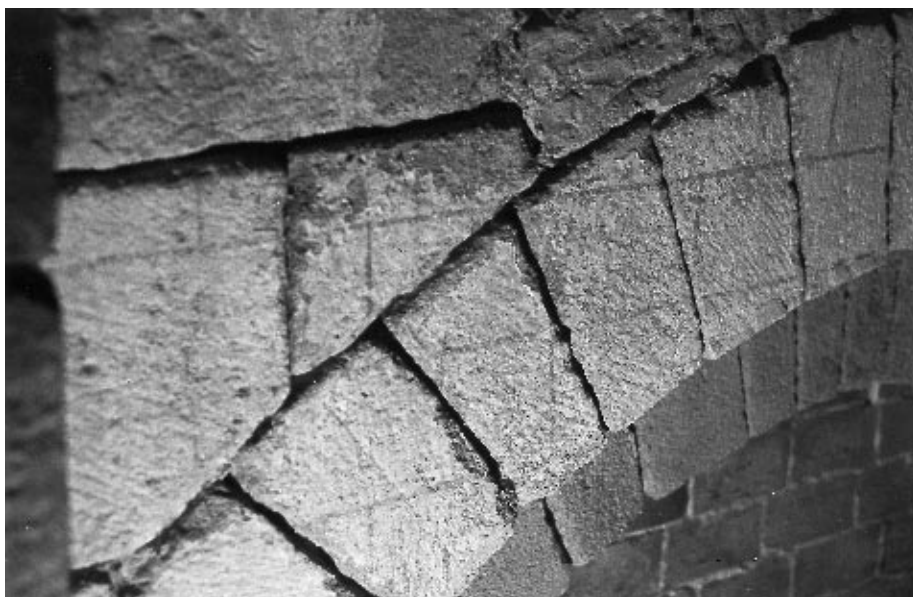
Fig. 11 : Le parement interne du mur nord de la nef, travée 1 : détail des faux joints sur fond blanc conservés au-dessus de la baie de la tribune. Notons que les "assises" ne respectent pas les claveaux (cf. Fig. 4a).
