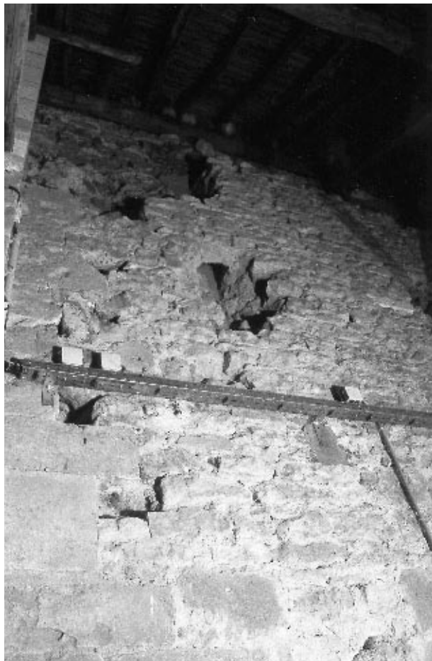
Fig. 23 : Le parement sud du mur sud de la nef : détail d'une loge de poutre verticale dans la maçonnerie de la reconstruction de la nef (cf. Fig. 22a).
