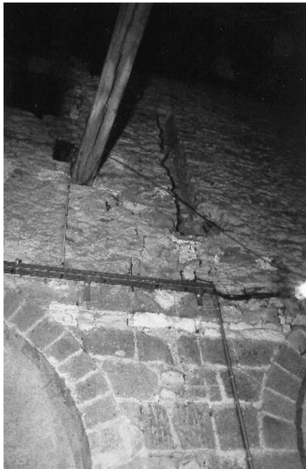
Fig. 24 : Le parement sud du mur sud de la nef : détail d'une loge de poutre verticale dans la maçonnerie de la reconstruction de la nef (cf. Fig. 22a').
