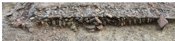
Fig. 78 – Le mur-pignon du portique sud effondré, vu en coupe du nord-ouest (cliché : A. Lanteri, Inrap).
