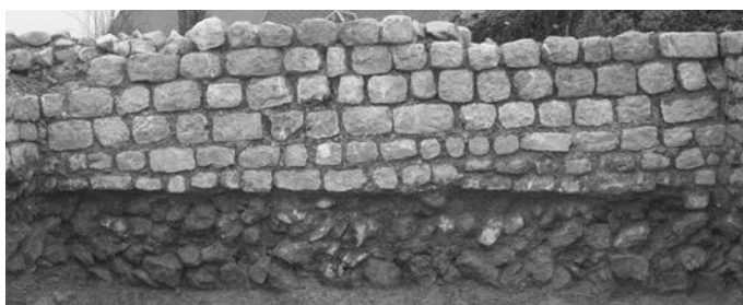
Fig. 12 – Exemple de parement composé de moellons de pierre bleue en opus vittatum jointoyés au mortier sableux jaune, vu du sud-ouest. Il s'agit de la face interne du mur nord de la pièce à abside de l'UA 1 (cliché : P. Neaud, Inrap).
