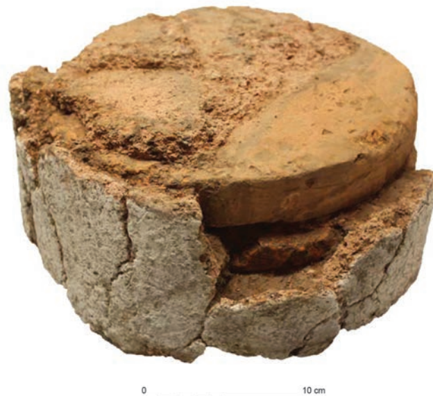
Fig. 29 – Fragment de fût de colonne de 0,31 m de diamètre, composé de trois briques circulaires et découvert dans le niveau de destruction du portique (cliché : P. Neaud, Inrap).
