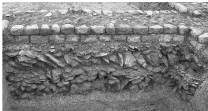
Fig. 11 – Exemple de hérisson de fondation (façade nord du temple 3) présentant deux assises en opus spicatum , séparées par une assise de nivellement. La transition entre le sommet du hérisson de fondation et le parement est marquée par un lit d'attente, vu du nord-est (cliché : D. Martins, Inrap).
