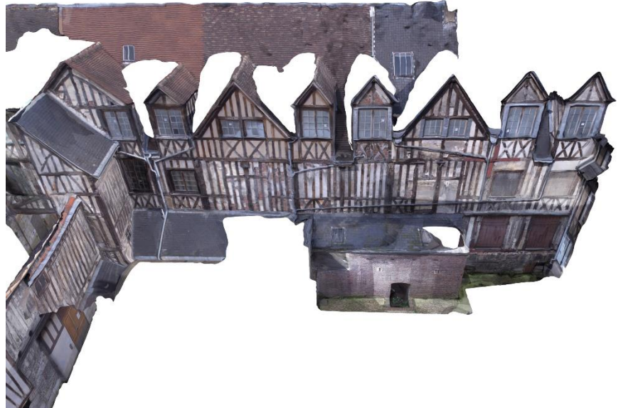
Fig. 8 : Relevé de façade dans une cour très encombrée. Aître Saint-Maclou, Rouen (76). A. Marais, Dendrotech, 2016.
