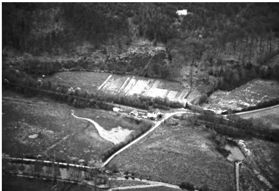
Fig. 2 : Calleville, le Bubot : vue aérienne générale du site © H. Paitier.
