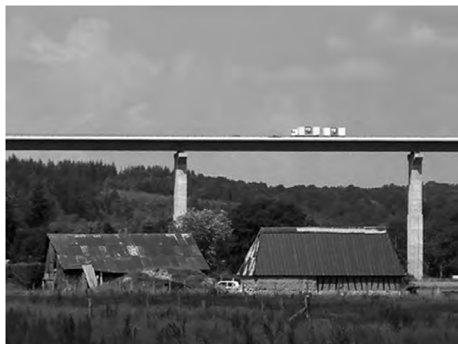
Fig. 3 : Le viaduc de la vallée du Bec © M. Biard.
