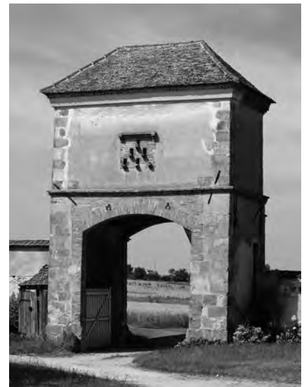
Fig. 34 : Porte monumentale de la ferme de la Folie à La Tombe, en Seine-et-Marne © S. Hurard.
