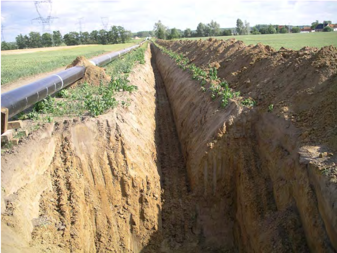
DOC 27 – Tranchée gazoduc, vue vers le nord depuis le puits OSL du Câtelet
