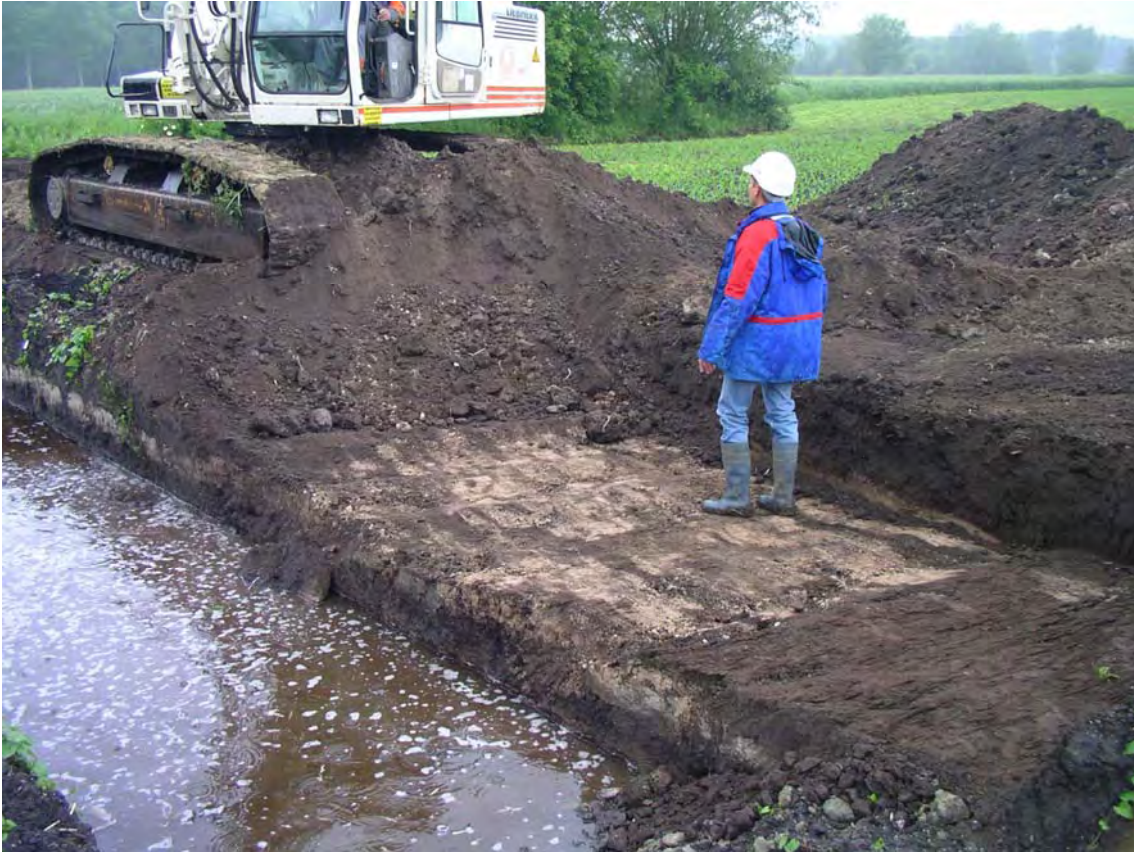
DOC 34 – Tuf en partie supérieure du remplissage du méandre de Vred
