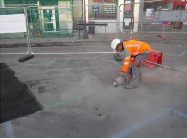
Fig.5 : préparation du chantier de la zone 3 (découpe de l'enrobée, par la société Eiffage.
