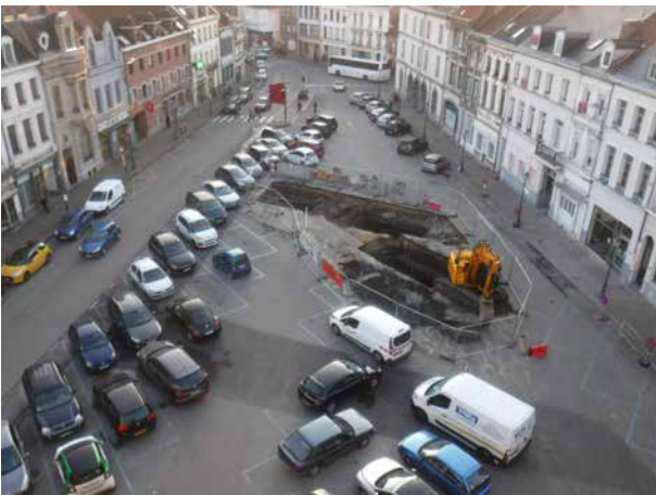
Fig. 9 : vue, prise de la mairie, des TR3 et 4 (phase 3) et de la zone de protection (grilles Héras). © Alain Henton - Inrap.
