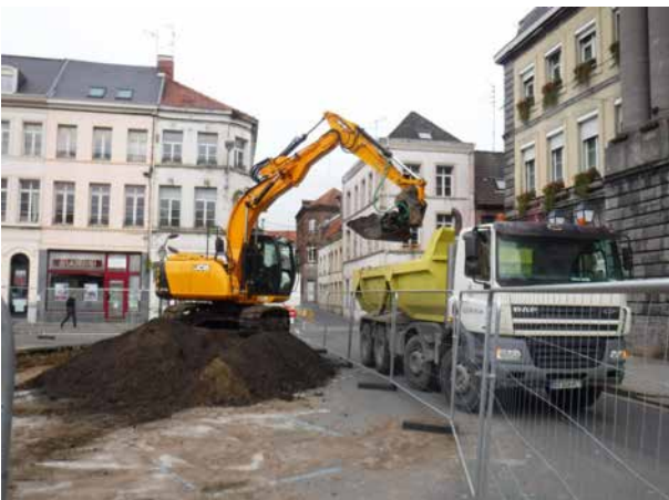
Fig. 11 : zone 1. Enlèvement des déblais de fouille par la société Eiffage. © Alain Henton - Inrap.
