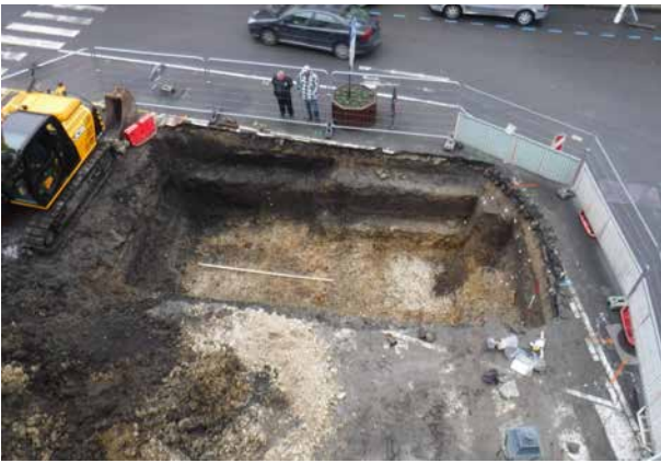
Fig. 8 : vue, prise du bâtiment du beffroi, de la TR2 (phase 2) et de la zone de protection (grilles Héras). © Alain Henton - Inrap.
