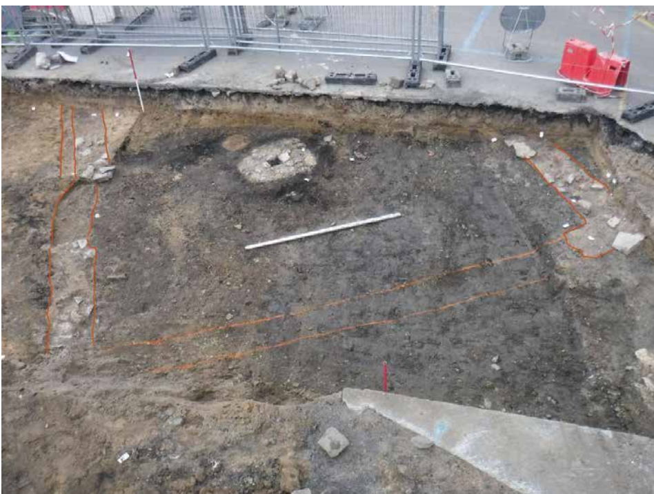
Fig. 88 : tranchée TR3. vue, prise de l'est, de la fondation carrée du monument (fin XVII e -début XVIII e siècle?) entourant la fondation 3046. L'interruption avec trace d'enlèvement de dalle de pierre est visible à gauche. © Alain Henton - Inrap.
