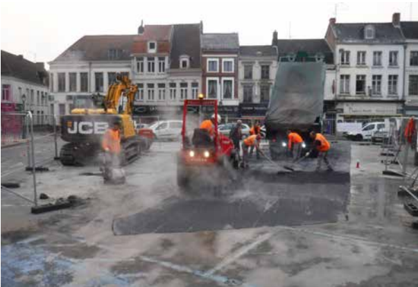
Fig.6 : remise en état de la place après la fin de la phase 1 (TR1). Pose d'un nouvel enrobé par la société Eiffage.
