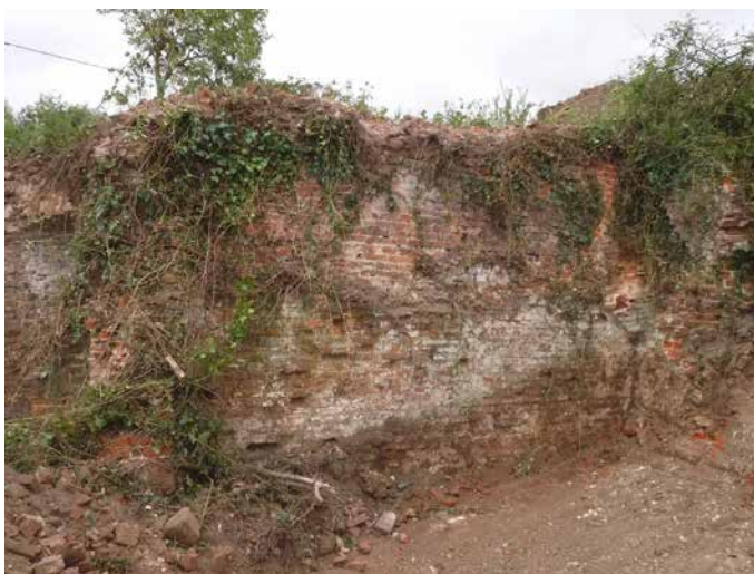
Fig.23 : vue du parement externe en élévation de la cave 1. © Evelyne Gillet - Inrap.
