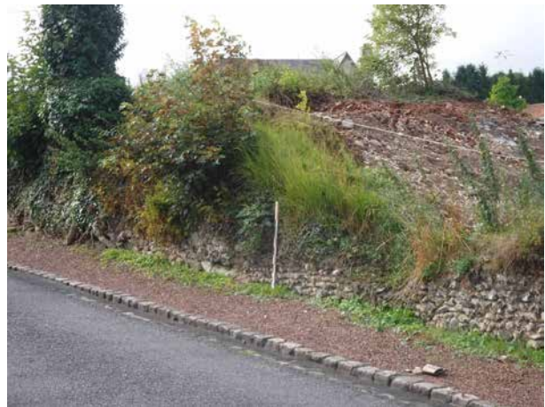
Fig.12 : détail du parement du mur de clôture (Us 1082). © Evelyne Gillet - Inrap.
