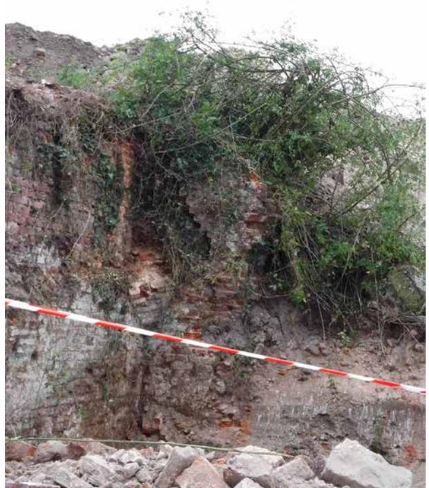
**Fig.9** : mur latéral sud de la cave 1. Risque d'effondrement imminent. Sécurisation des abords.
