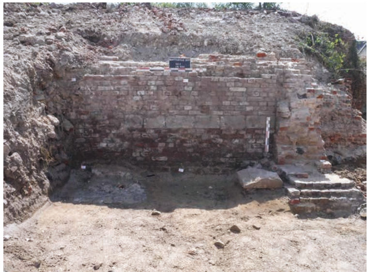
Vue d'ensemble du parement de la façade nord-ouest
