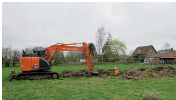
Fig.5 : Pelle mécanique 15 tonnes. © Cécile Durin - Inrap.
