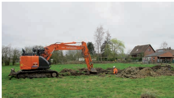
Fig.5 : Pelle mécanique 15 tonnes. © Cécile Durin - Inrap.
