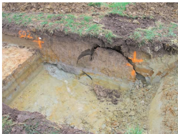
Fig.7 : Effondrement de paroi dans le sondage du fossé 17. © Cécile Durin - Inrap.
