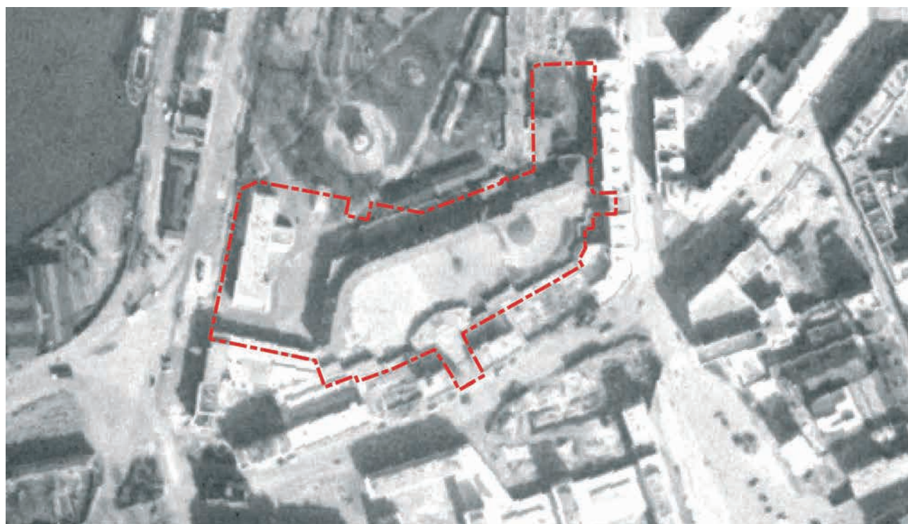
Fig. 14 : En 1953 (en haut), la reconstruction a débuté ; le nouveau réseau viarie est désormais en place. En 1957 (en bas), les bâtiments sont construits ; au centre de l'emprise, l'école élémentaire du Parc de la Marine, à gauche, le bâtiment des Affaires Maritimes
