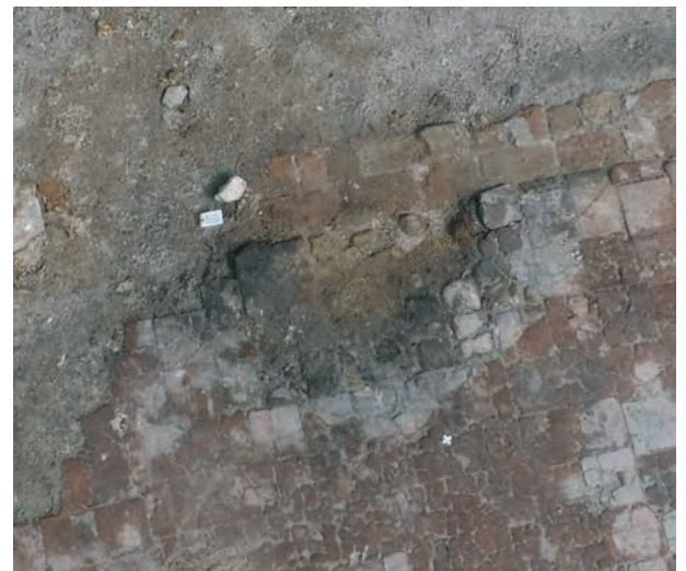
Fig. 73 : Sd. 12 - Zone de carrelage brûlée le long du mur 104 Cliché : © Thierry Marcy - Inrap
