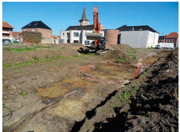
Fig. 26 : tranchée 3, zone de petits creusements depuis le sud-est. © Ludovic Notte - Inrap.
