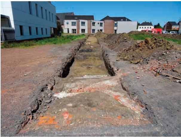
Fig.10 : tranchée 1, extrémité méridionale, maçonneries contemporaines, depuis le sud.
