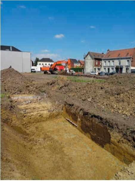
Fig. 21 : tranchée 2, coupe de la Str. 33, depuis le sud. © Ludovic Notte - Inrap.
