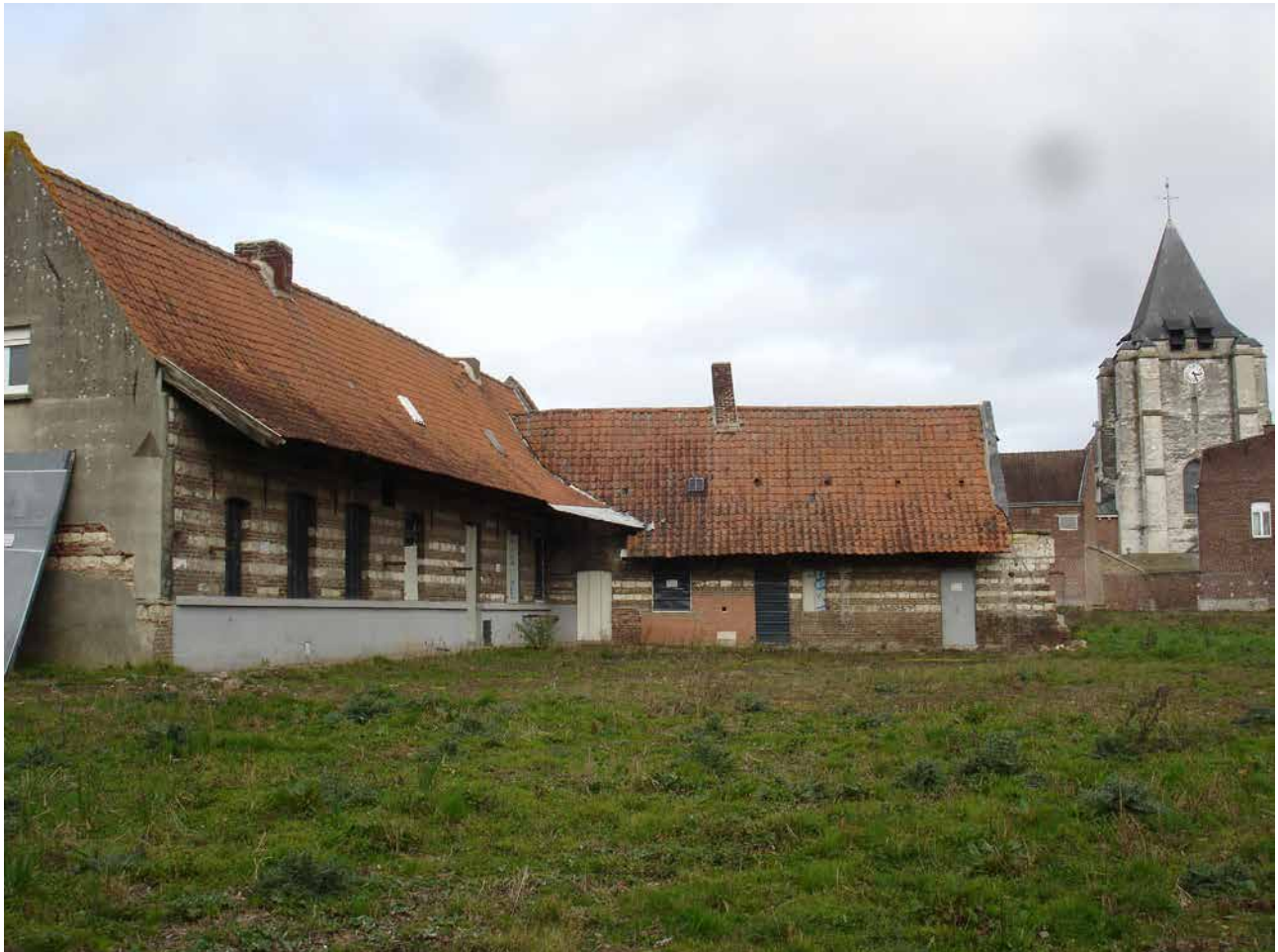
Fig.3 : photographie de la partie de la ferme conservée dans le projet (en arrière plan l'église Saint Lambert). © Emmanuel Elleboode - Inrap.
