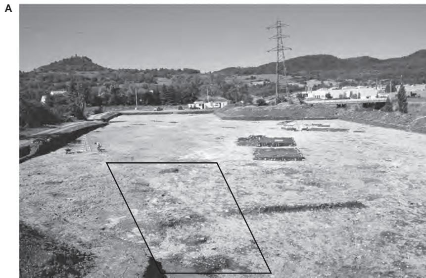
Fig. 75 : Les Foisses. A : vue de la batterie de foyers F 1006 vers l'ouest ; B : détail des foyers fouillés du secteur 3 au secteur 2 (secteur 1) (cliché S. Saintot, DAO G. Macabéo).
