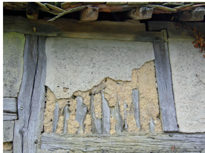
Fig. 20: Détail de clayonnage en terre et bois sur un édifice moderne, Vallée de la Besbre (03). © P. Mille.
