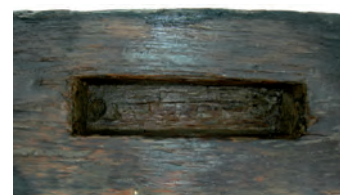
Fig. 9. Mortaise de la sablière 503. © P. Mille.
