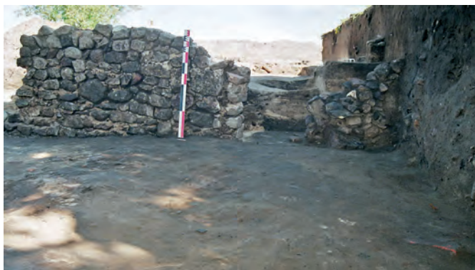
Fig. 5. Détails de l'élévation du mur occidental du bâtiment F28, depuis l'ouest. © F. Baucheron.
