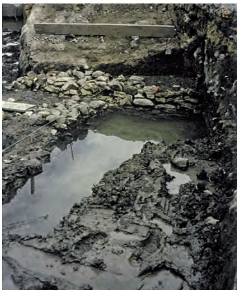
Fig. 3. Vue de la plate-forme. © S. Gaime.
