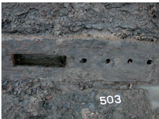
Fig. 12. Détail de la sablière 503. © P. Mille.
