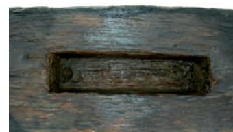
Fig. 9. Mortaise de la sablière 503. © P. Mille.
