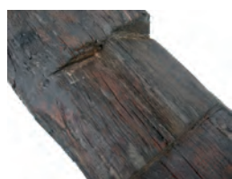
Fig. 10. Encoche sur la sablière 503. © P. Mille.
