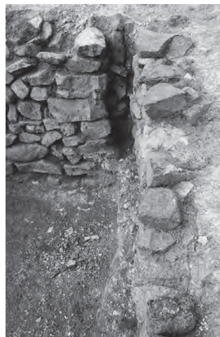
Fig. 10. Négatif du poteau 311 (bâtiment 1) laissé en réserve dans la maçonnerie. © S. Gaime.
