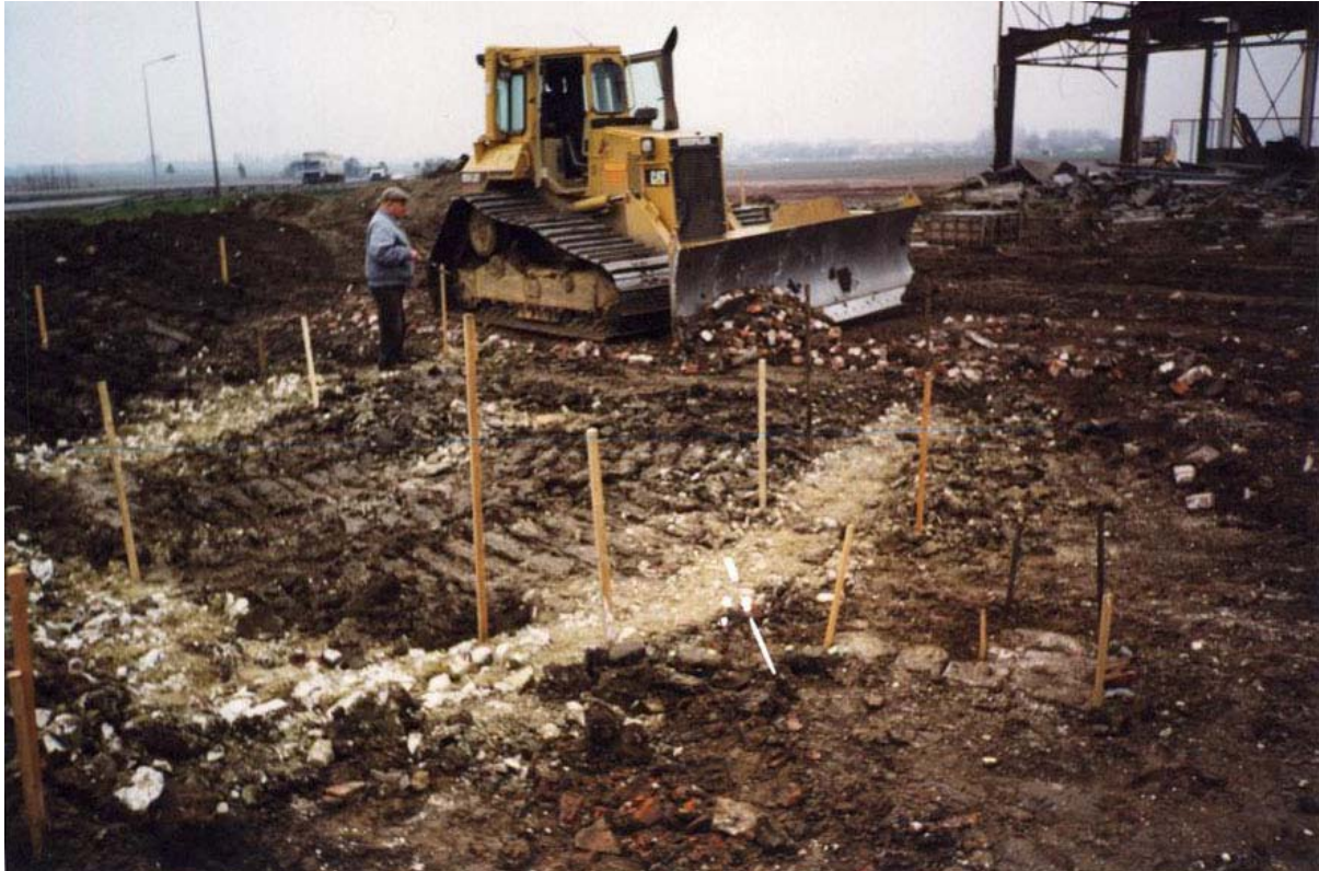
Fig. 3 : Photographie de la destruction de la station service avant la construction du magasin Chrétien, Document SRA.
