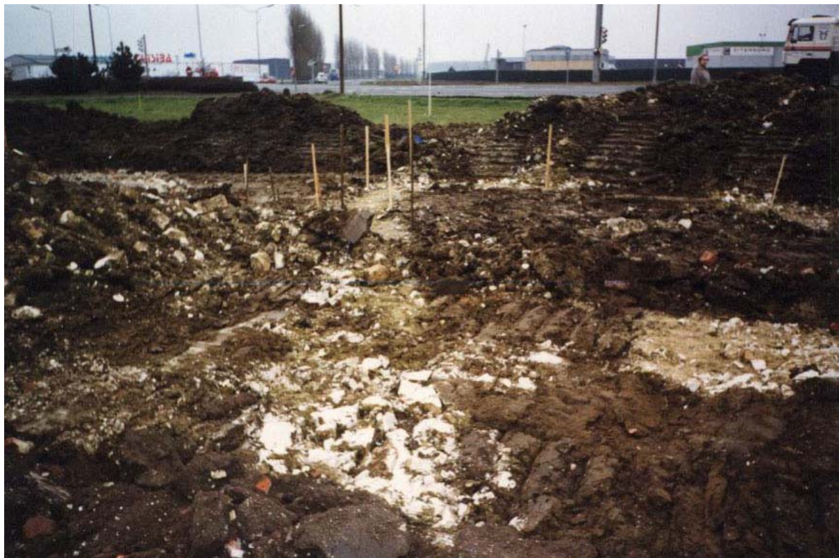
Fig. 4 : Photographie de la destruction de la station service avant la construction du magasin Chrétien, Document SRA.
