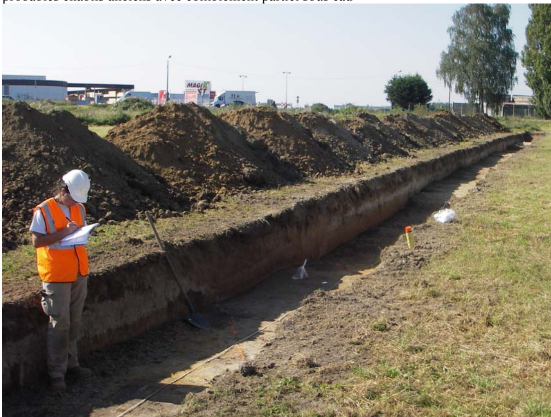
Photo 22 – Vue générale de l'extrémité ouest de la tranchée étudiée
