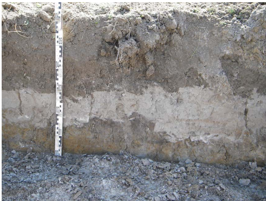
Photo 14 – Log 9, vue générale
