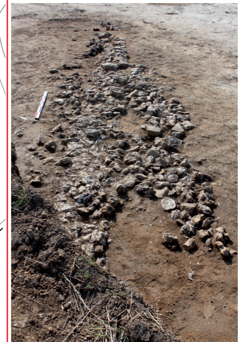
Démolition du mur 1016
