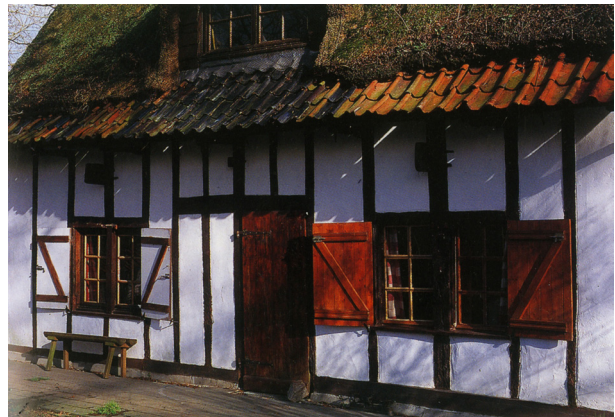
Fig.95 : Exemple d'une maison flamande à Wormhout en couverture mixte. © Johan Vansteenkiste.
