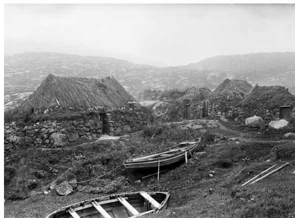
Fig. 27 – Black houses à Ceann Tangabhal (Kentangaval), île de Barra, Hébrides. Noter les pierres posées de chant à la base des murs de la maison de gauche (photographie Erskine Beveridge, 1898, © RCAHMS).
