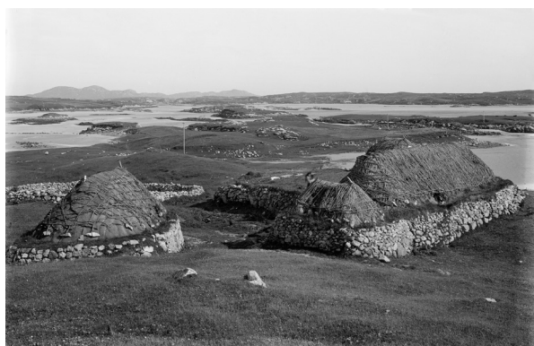
Fig. 26 – Black houses à Eilean a' Ghiorr, île de North Uist, Hébrides. Ces maisons en pierres sèches datent probablement du début du XIX e siècle. Les toits sont couverts de chaume (maison de droite) ou de mottes de pelouse retournées (maison de gauche), le tout maintenu par un réseau de cordages lesté par des pierres. Aux extrémités du faitage, deux bâtons, nommés les « bâtons de corbeaux » (raven-sticks), servent de point d'ancrage au réseau de cordes (photographie Erskine Beveridge, 13/08/1906, © RCAHMS).
