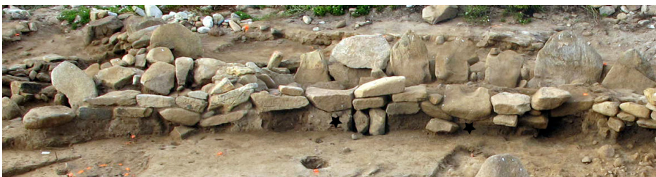
Fig. 10 – Vue générale du parement interne UA 2a. On distingue les deux fragments de meule en réemploi (étoile noire). Entre les deux étoiles, deux petites pierres de bout sous la première assise du parement correspondent à un étai réalisé lors de la fouille et non à un fait archéologique.
