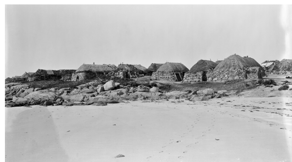
Fig. 28 – Black houses à Hogha Gearraidh (Hougharry), île de North Uist, Hébrides. Ces maisons traditionnelles ont des murs épais, avec des parements en pierres sèches et un bourrage fait de tourbe et de terre. Le toit repose sur le parement interne des murs et le chaume vient couvrir le bourrage. De cette manière, la pluie ruisselle sur le chaume jusqu'au bourrage, renforçant ses propriétés isolantes du froid et du vent. La partie sommitale du parement externe reste à l'air libre, formant un rebord sur lequel il est facile de marcher, par exemple pour réparer ou remplacer le chaume (photographie Erskine Beveridge, 17/8/1904, © RCAHMS).
