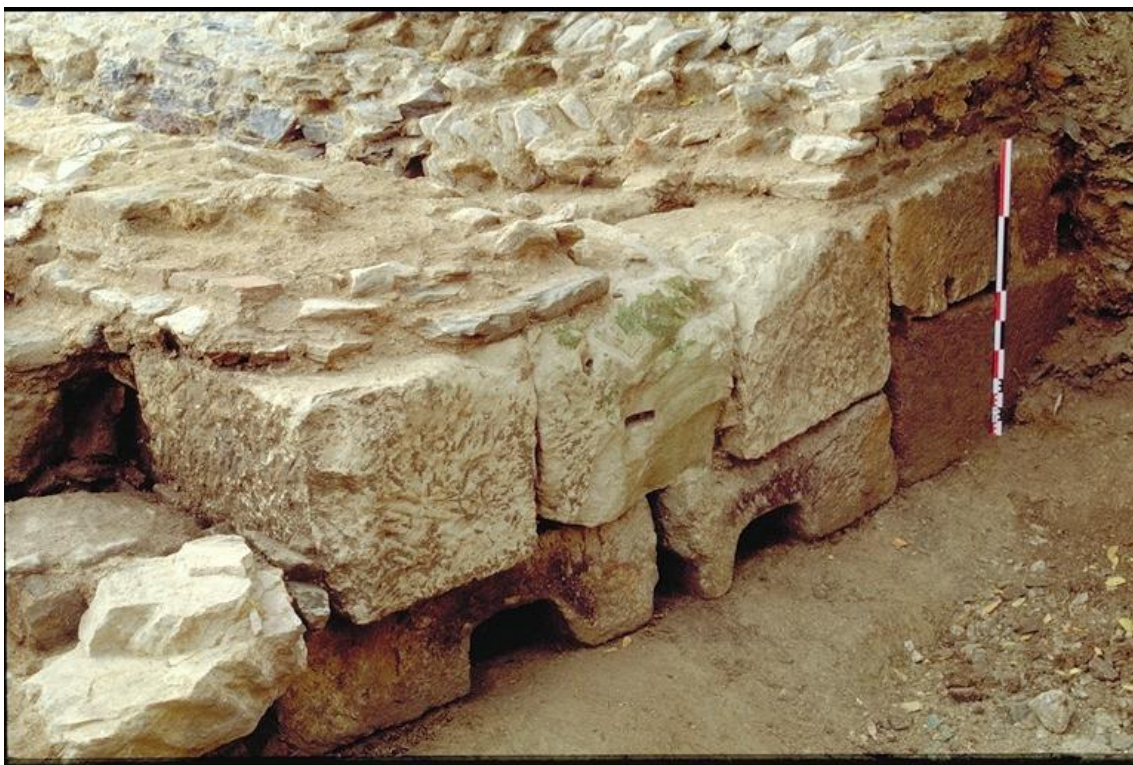
Blocs d'architecture monumentale réemployés en fondation de la muraille Place Foch (cliché D. Pouille, Inrap).
