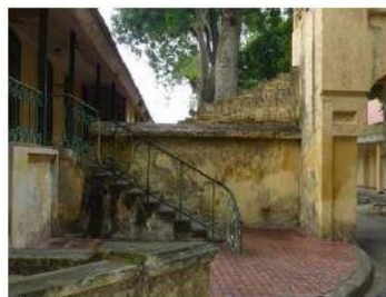
Détail façade Sud
