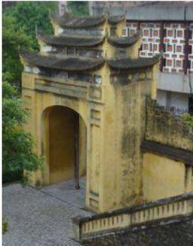
Façade Sud, porte principale
