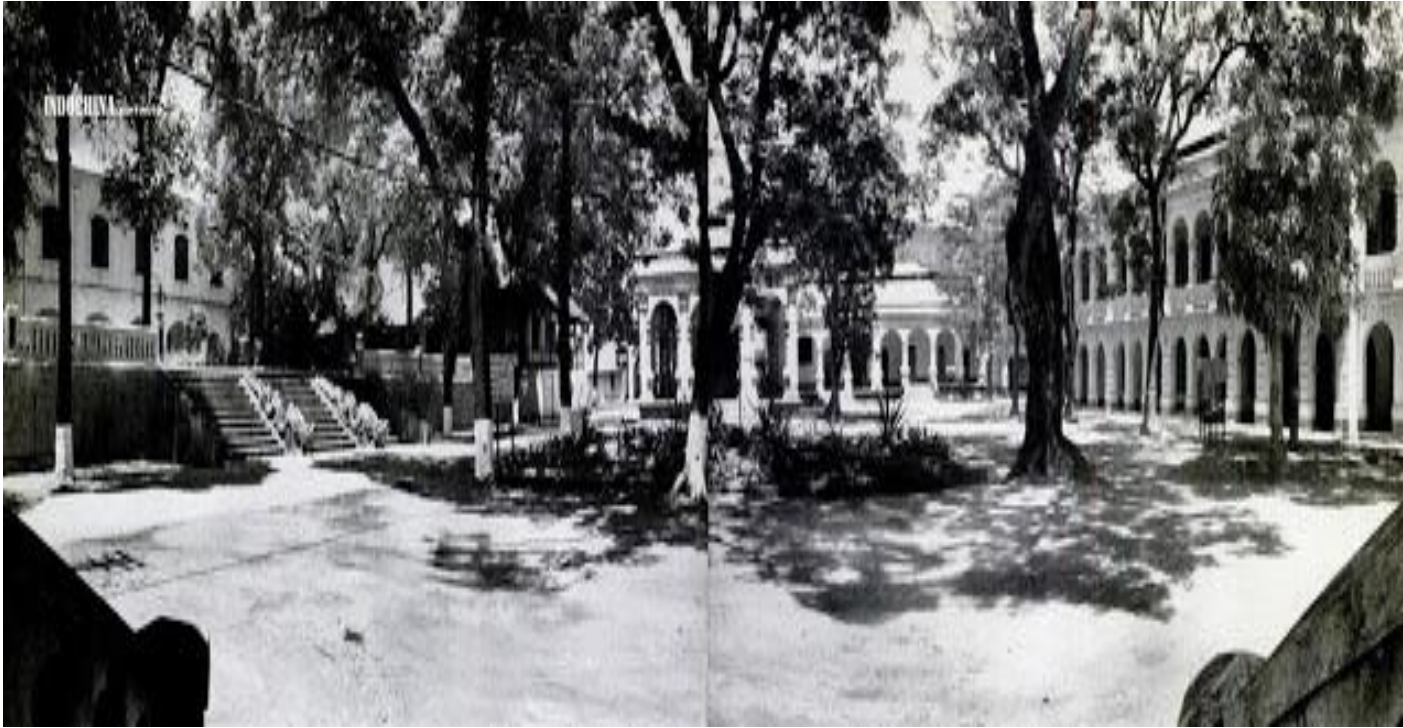
Fig.83. Direction de l'Artillerie, sur la partie gauche l'escalier de la Pagode royale, 1953.
