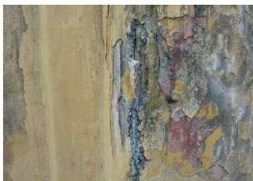
Etat des enduits
