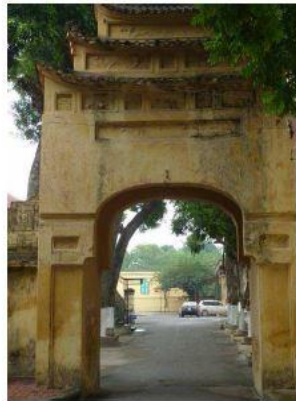
Détail façade Sud
