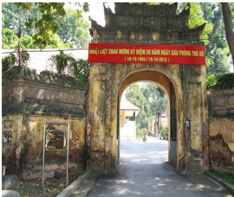
Fig.61. La porte OUEST, état actuel.
