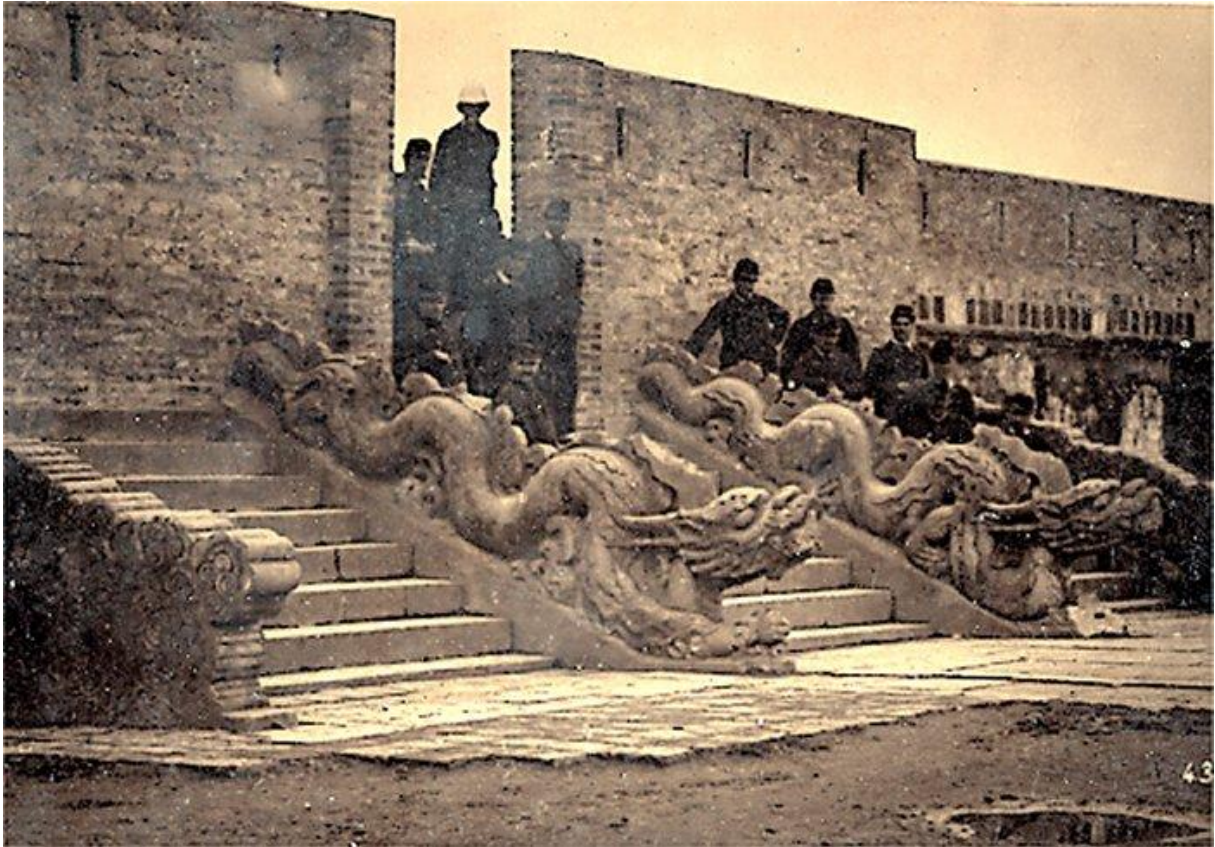
Fig.53. La pagode royale, source ANOM vers 1886, rajout de murets supplémentaires avec meurtrières.
