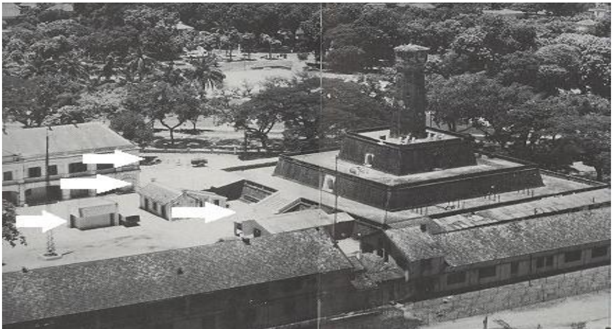
Fig.33. La tour de la citadelle, bâtiments démontés flèches blanches, 1950.
