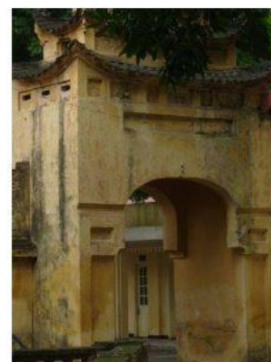
Angle sud - ouest
