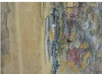
Etat des enduits
