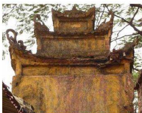
Détail façade Est
