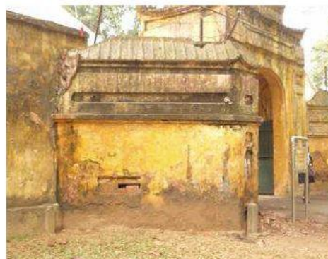
Détail redoute rapportée - façade Ouest
