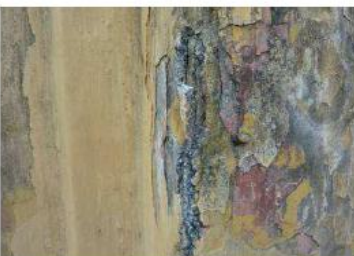
Etat des enduits
