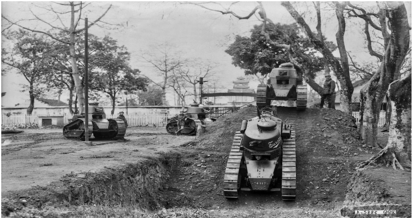
Fig.71. Manoeuvres de chars FT-17 dans l'enceinte de la citadelle, source ANOM, années 30.
