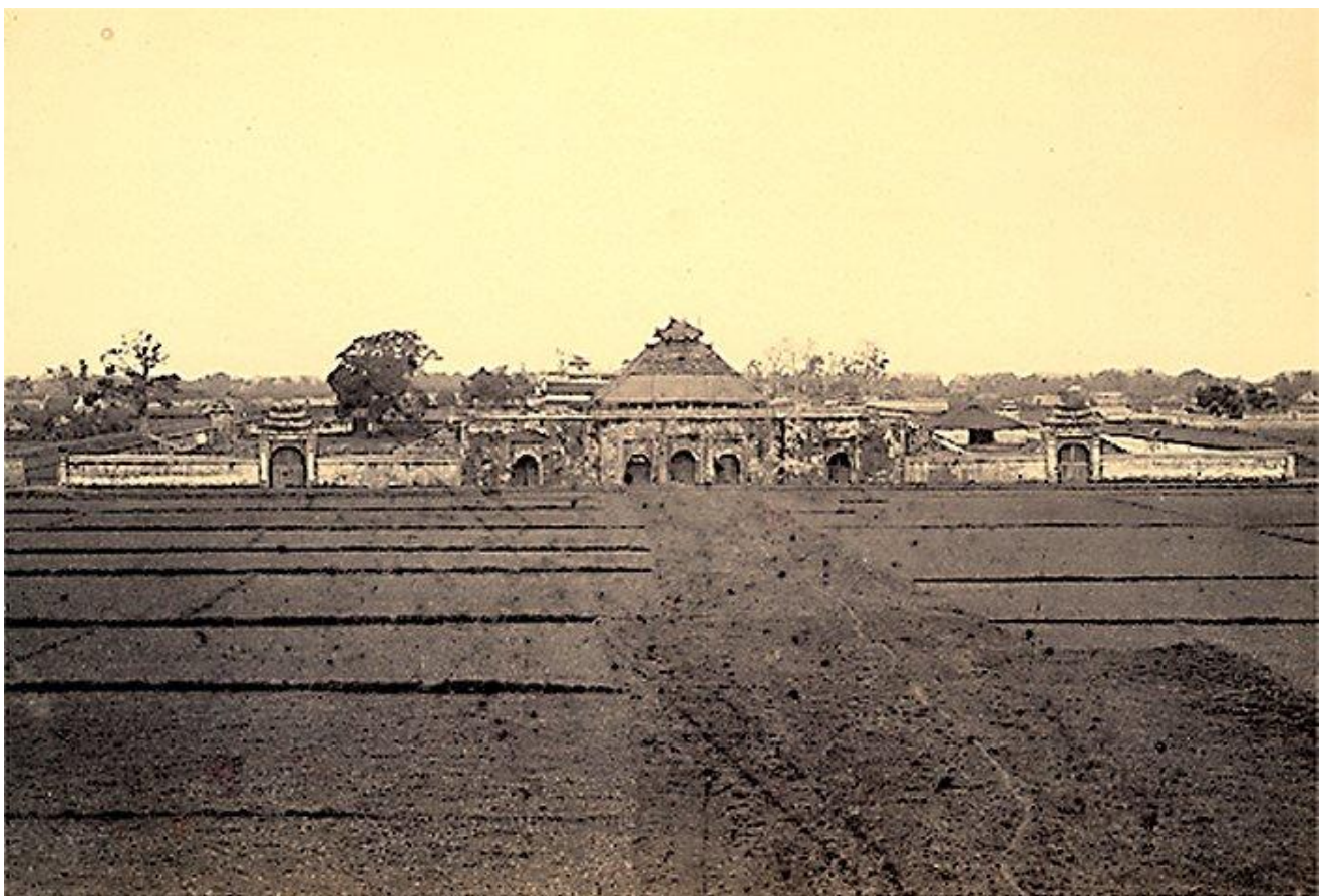
Fig.97. Le réduit de la citadelle, Charles-Edouard Hocquard, 1884, FRANOM 49 FI 1/13.
