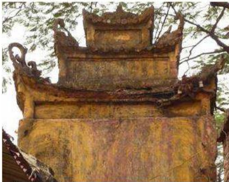
Détail façade Est
