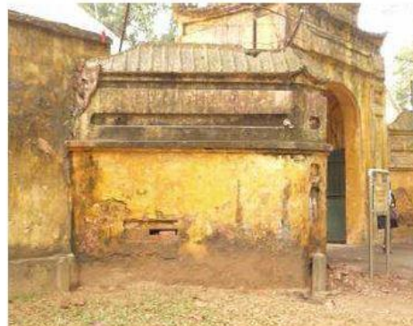
Détail redoute rapportée - façade Ouest
