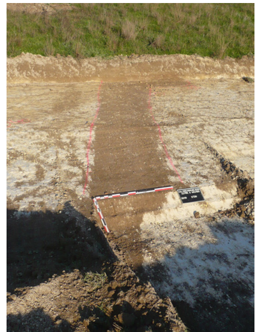
Vue depuis le sud-est du fait 39.
