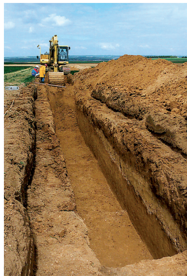
Fig. 2. Sondage en puits avec rampe et plateforme pour engin de terrassement. Cette technique permet de descendre à 8 m de profondeur. © P. Depaepé, Inrap.
