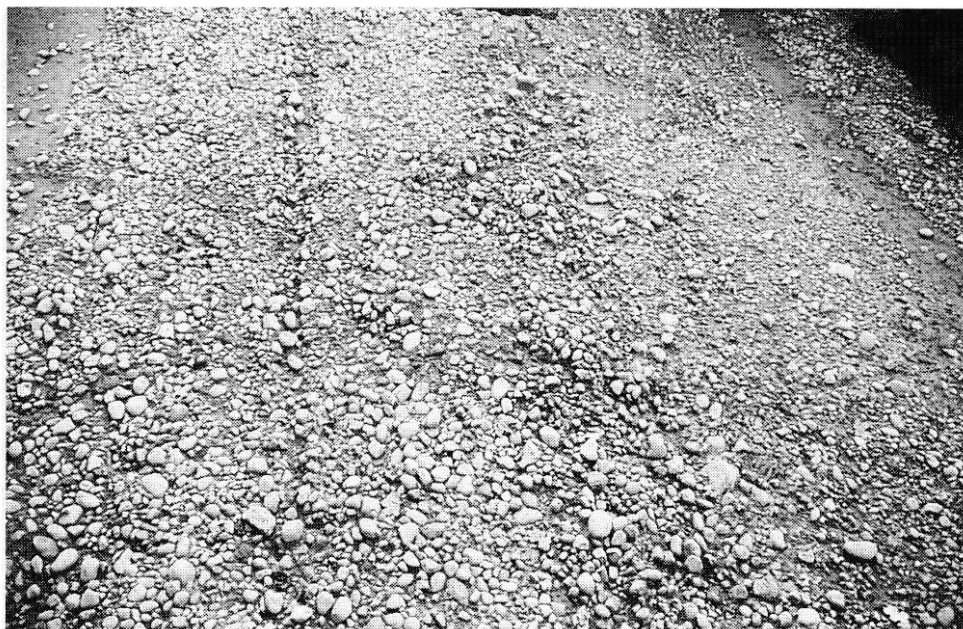
16 - L'empierrement, qui a conservé des traces d'ornières plus ou moins profondes, montre des différences de structure entre les parties haute et basse
