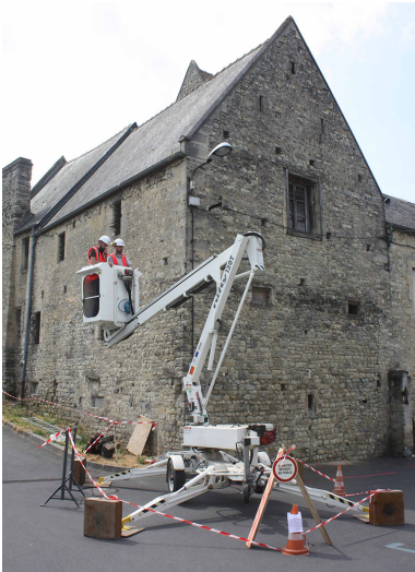
Fig. 11 - Réalisation d'une orthophotographie des façades de l'Hôtel du Croissant (53, rue Saint-Jean) à Bayeux (Calvados). (Conseil départemental du Calvados, 2014)
