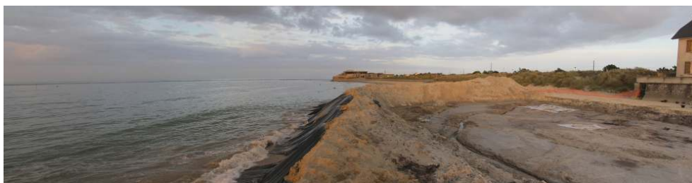
Fig. 1. Digue de sable enveloppée de bâche en plastique protégeant l'aire de fouille.
