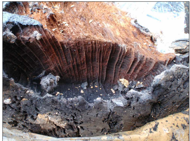
Fig. 3.11-05 ter : Dégradation des poutres du puits : destruction de la cellulose (les rayons ligneux, plus résistants et plus chargés en lignine, apparaissent en fort relief ; cl. B. Lecomte-Schmitt, Inrap)
