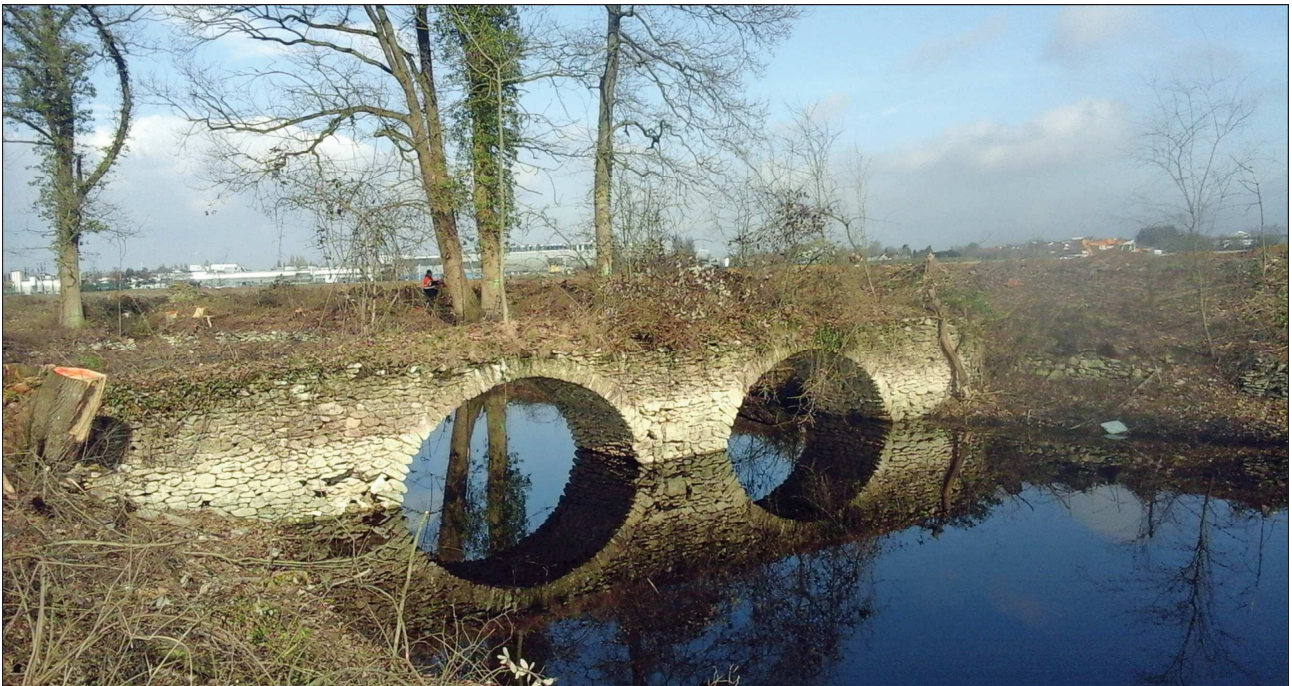
Pont à deux arches du Champtier du Chêne Mort , depuis le SSO, 17/02/2017
