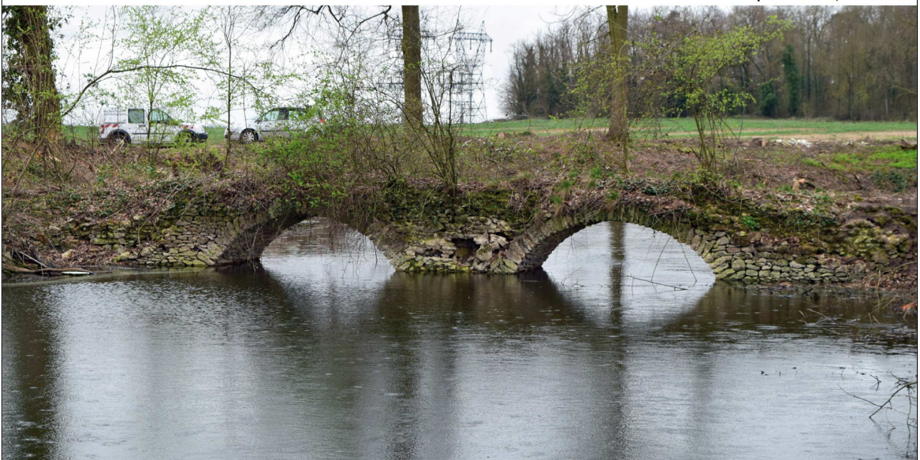
Fig 55: Vues du pont à deux arches de la mare du Champtier du Chêne Mort , février et mars 2017 (© INRAP : G. Desrayaud, Ph. Lenhardt)
