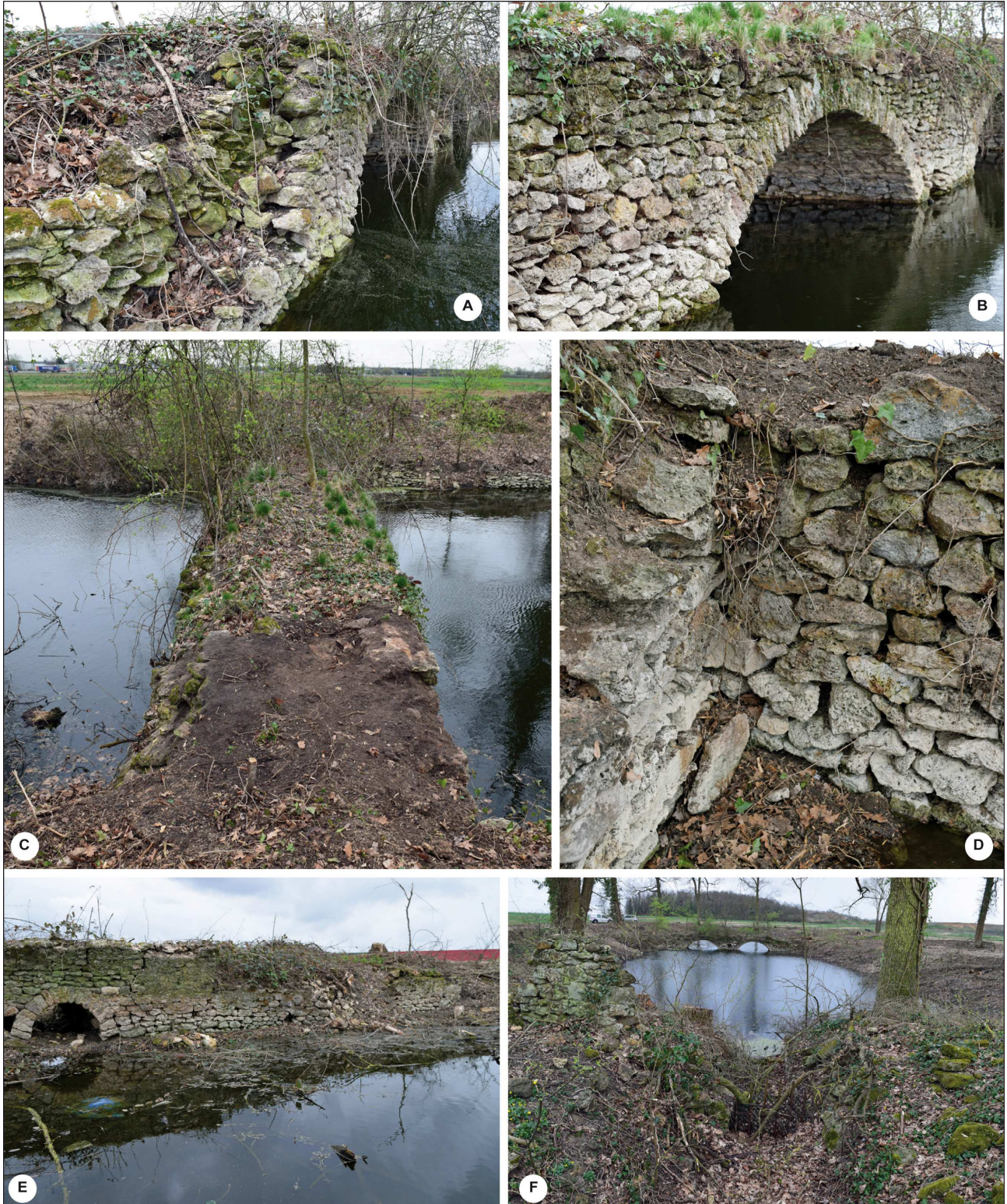
Fig 56: Vues du pont à deux arches et des aménagements de la mare parementée du Champtier du Chêne Mort , 21 mars 2017 (© INRAP : Ph. Lenhardt)
