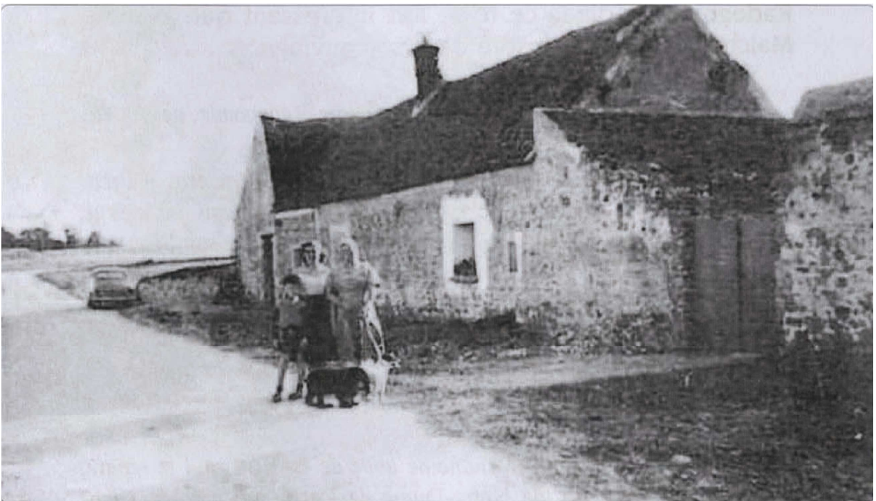
Les fermes de Tournenfiles ont été démolies en 1970
