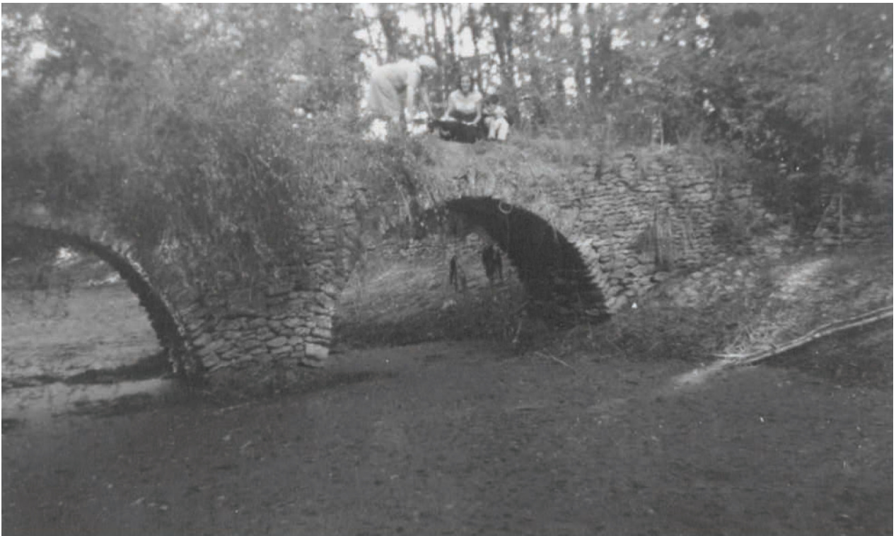
Pont à deux arches du Champtier du Chêne Mort (cliché par Marius Courtin le 12 juin 1976)
