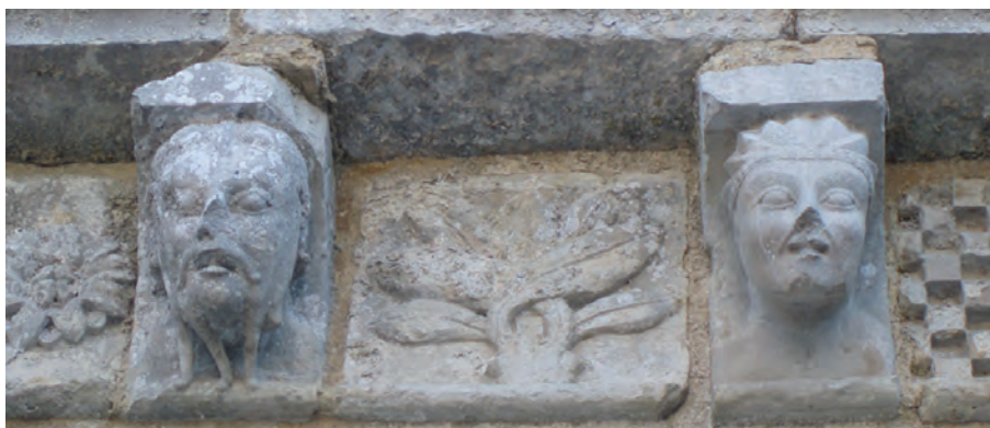
fig. 5b : Corniche de la façade ouest de l'église paroissiale de Retaud (Charente-Maritime) (cliché C. de Mecquenem, Inrap)
