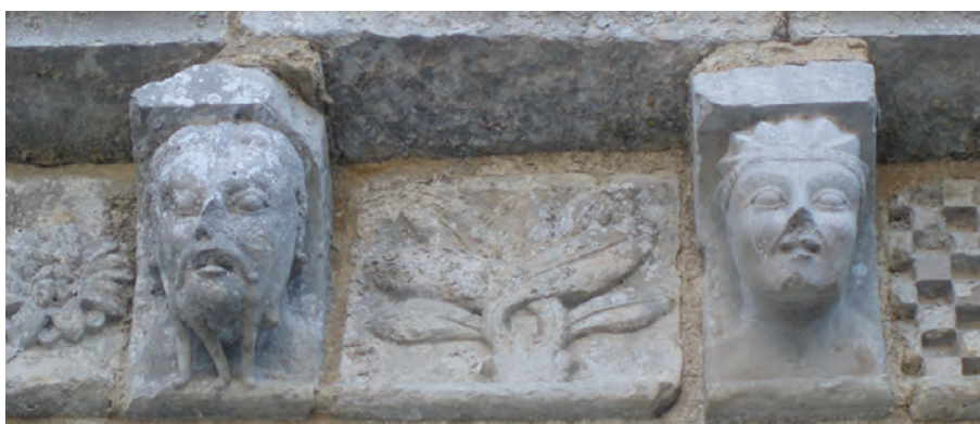
fig. 5b : Corniche de la façade ouest de l'église paroissiale de Retaud (Charente-Maritime) (cliché C. de Mecquenem, Inrap)
