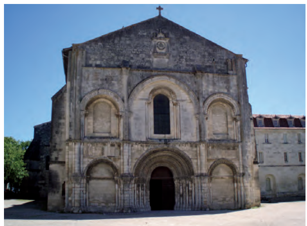
fig. 9 : Façade de l'abbatiale Sainte-Marie de l'Abbaye-aux-Dames de Saintes (Charente-Maritime) (cliché C. de Mecquenem, Inrap)
