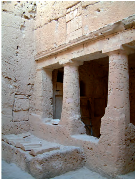
fig. 3 : Vue de la pièce 5 depuis la cour de l'hypogée 3 (cliché P. Georges, Inrap / MFFTM)
