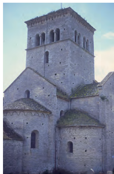
fig. 2b : Eglise paroissiale de Malay (Saône-et-Loire) (cliché C. de Mecquenem, Inrap)
