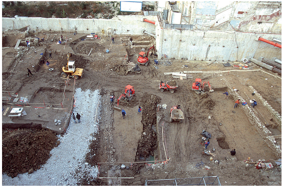
Fig. 1. Un secteur du chantier de l'Alcazar en cours de fouille. Noter la piste pour l'évacuation par camions au premier plan, renforcée avec de la grave, le tas tampon à proximité et les chemins de planche pour les piétons au fond.
