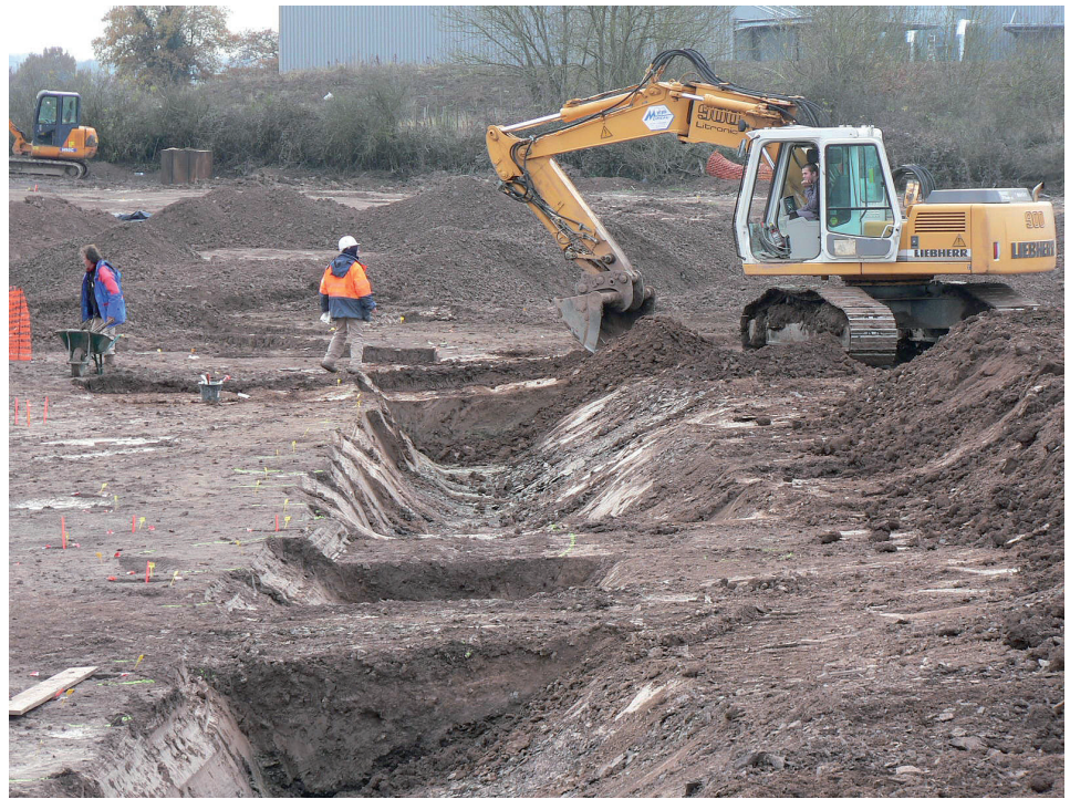
Fig. 5. Le recours régulier à la pelle mécanique de 20 t dans la fouille des imposants fossés d'enclos des habitats d'époque gauloise permet de réaliser de nombreux sondages, de récupérer ainsi de nombreux mobiliers et de multiplier les coupes stratigraphiques de référence. © Y. Viau, Inrap.
