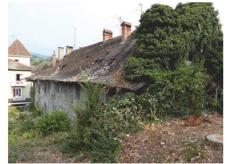
FACADE SUD, vue depuis l'est vers l'ouest
