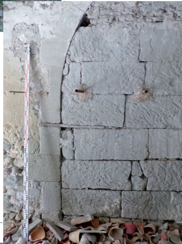
Vue de la porte murée US 147
