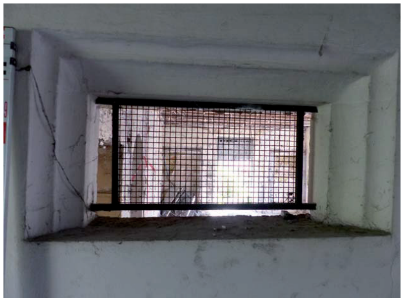
Fig. 13 : façade nord – vues de détail des baies à doubles croisillons US102, US103 et de la demi-croisée US104
