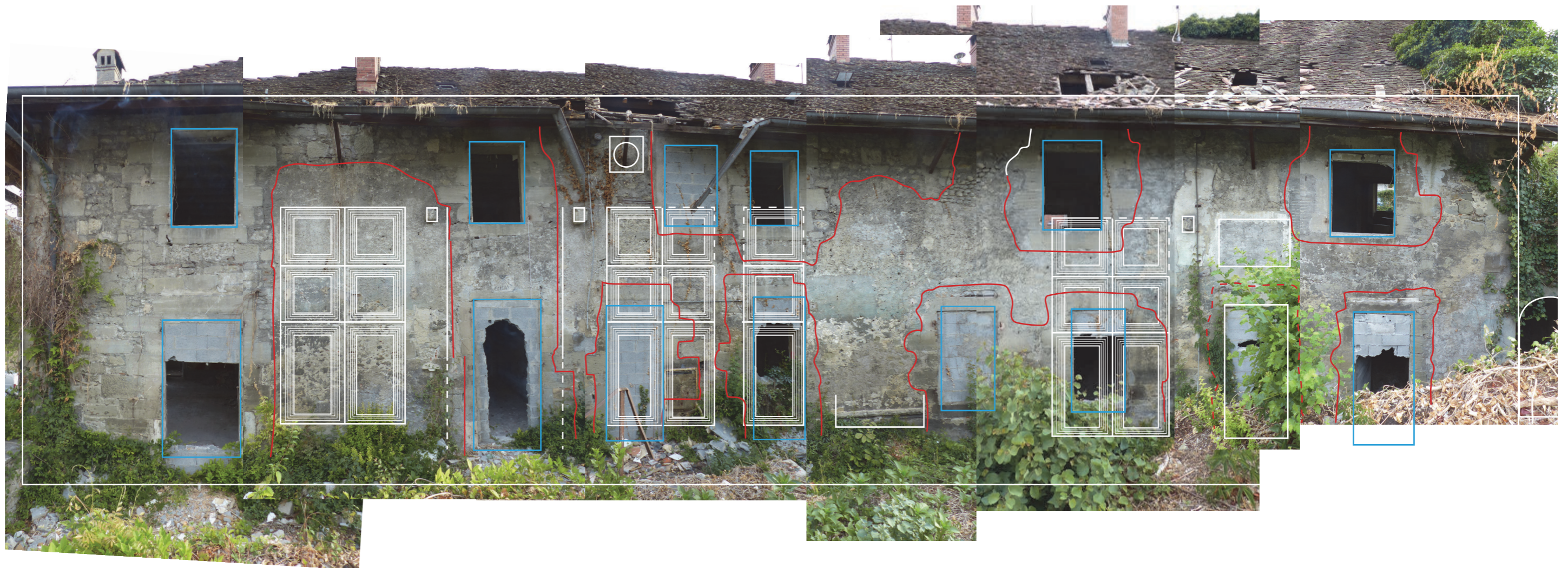
Angle SUD-OUEST Côté rue
