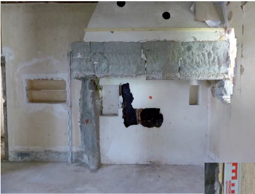
Vue générale de la cheminée US144
