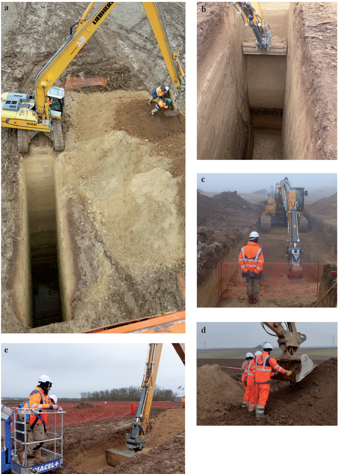
Fig. 8 - Méthodes employées pour la réalisation des diagnostics : a et b – exemples de sondages en puits réalisés à l'aide de la pelle hydraulique à bras rallongé (N. Schneider, Inrap) ; c – plateforme d'observation mise en place lors d'un sondage en puits à la pelle hydraulique (F. Bachelierie, AA) ; d – contrôle manuel du contenu du godet (F. Bachelierie, AA) ; e – nacelle utilisée pour l'observation des logs stratigraphiques lors des sondages réalisés à la pelle à bras rallongée (F. Bachelierie, AA). AA = Archéologie Alsace.
