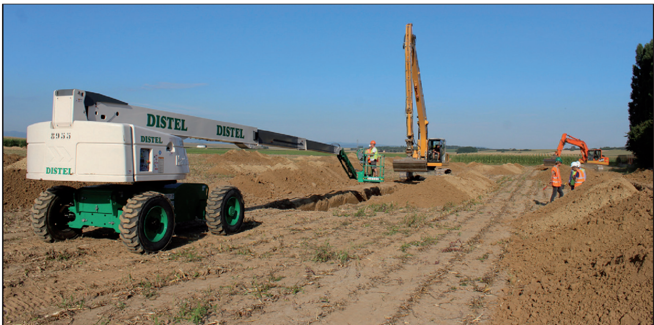
Fig. 5 - Sondages : a – en puits ; b – en palier de Reiningue-Krebsacker (LGV Rhin-Rhône). (Steiner & coll., 2012)
