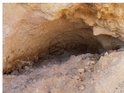
Galerie partiellement comblée
