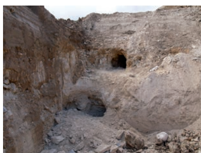
Galerie ouverte sur deux niveaux
