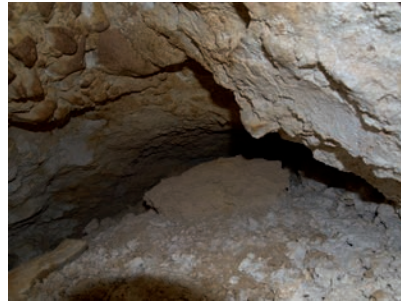
Galerie partiellement non comblée
