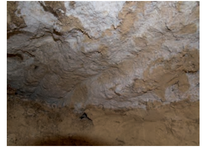
Traces d'outils sur le plafond d'une galerie
