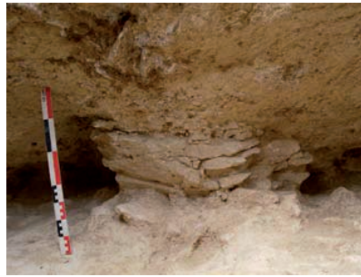
Pilier de calcaire conservé entre deux galeries
