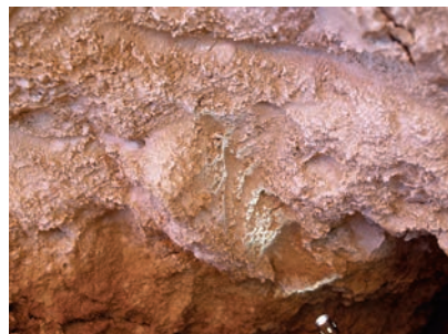
Traces d'outils sur la paroi du puits
