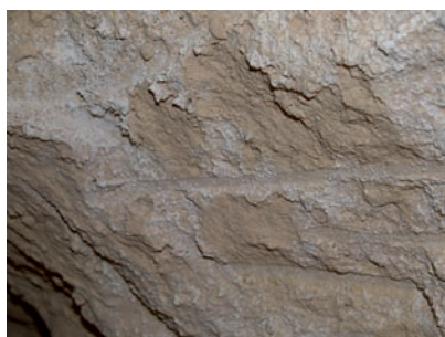
Traces d'outils sur le plafond d'une galerie
