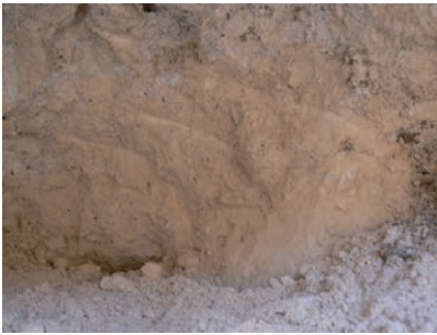
Traces d'outils sur la paroi du puits
